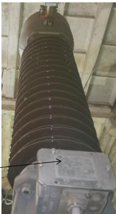
Рисунок 1 – Общий вид трансформатора тока с указанием места нанесения заводского номера
