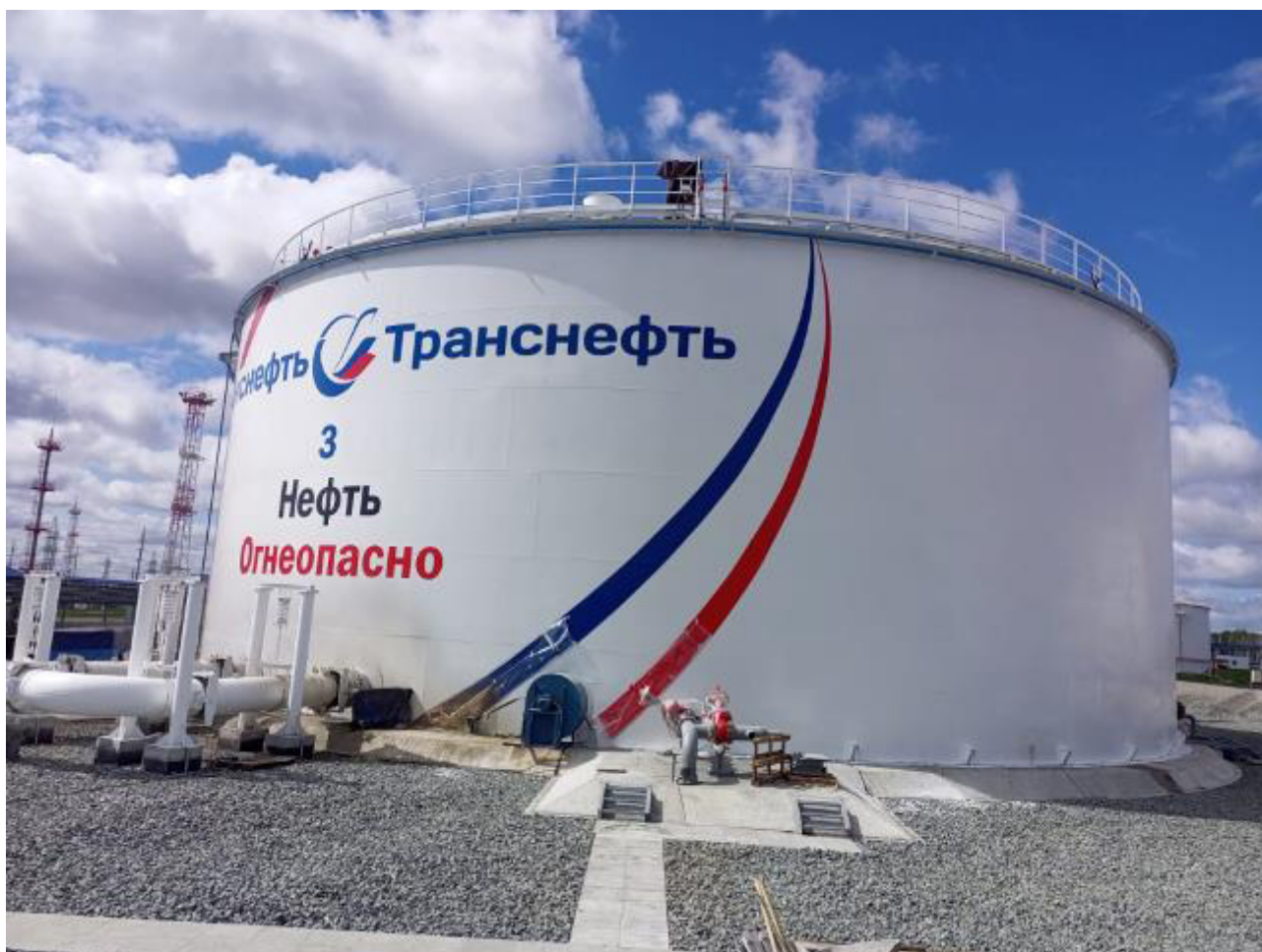
Рисунок 1 – Общий вид резервуара РВС-10000 №3
