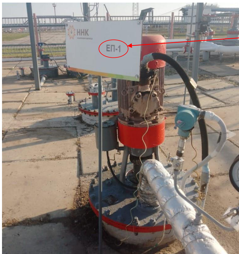
Рисунок 5 – Общий вид резервуара, замерного люка и место нанесения заводского номера РГС-15 зав. № ЕП-1
