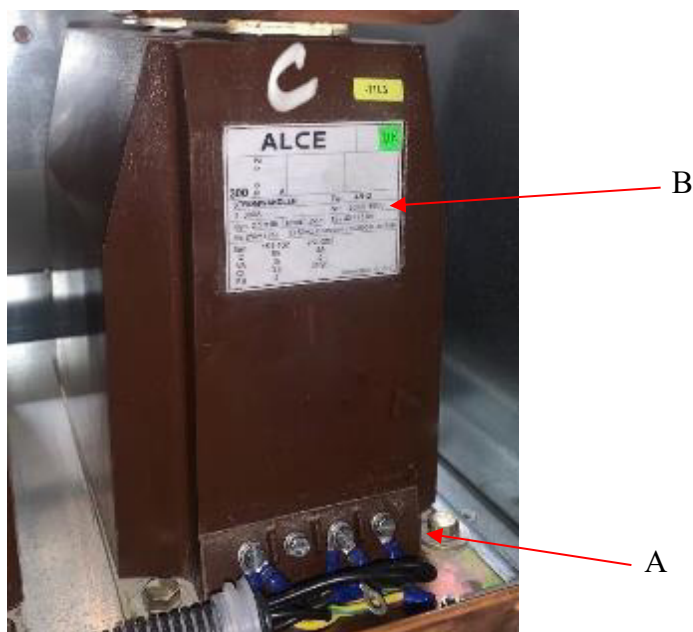
Рисунок 1 – Общий вид средства измерений, обозначение места пломбировки от несанкционированного доступа (А) и места нанесения заводского номера (В)
