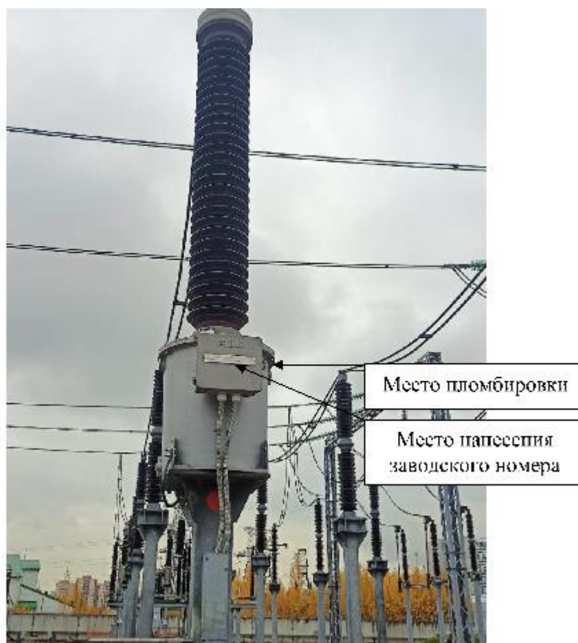
Рисунок 1 – Общий вид средства измерений с указанием места пломбировки, места нанесения заводского номера
