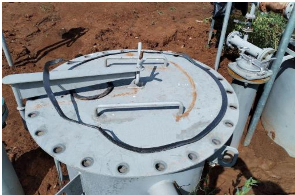
Рисунок 4 – Горловины резервуара ЕП-12,5-1990-1260 зав.№ 165
