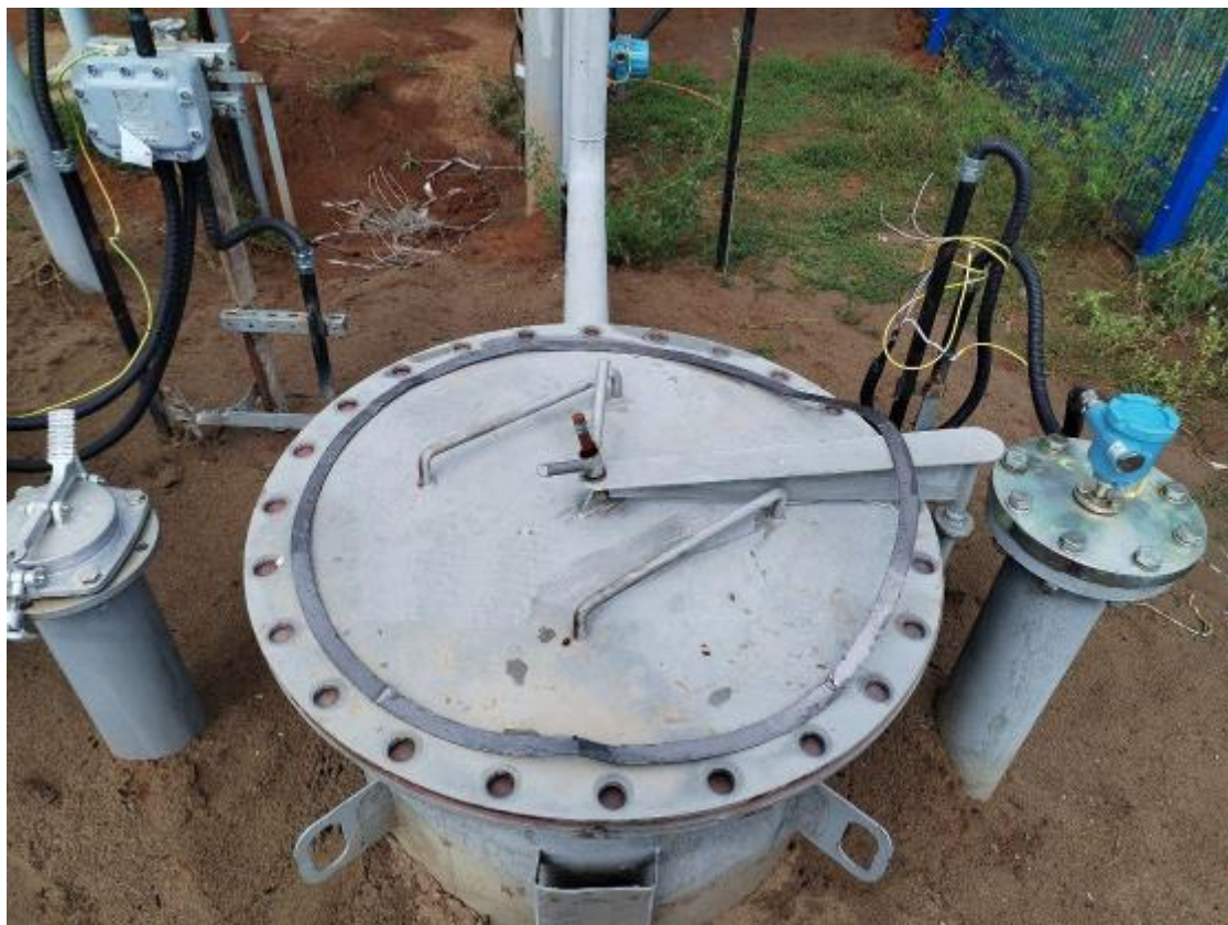
Рисунок 3 – Горловины резервуара ЕП-12,5-1990-1300 зав.№ 161
