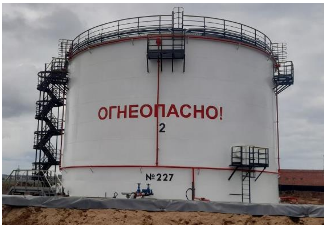
Рисунок 2 – Общий вид резервуара РВСП-3000 зав.№227
