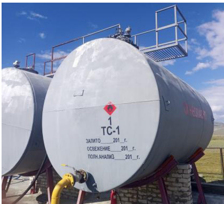
Рисунок 1 – Общий вид резервуара РГС-25 зав.№ 1
