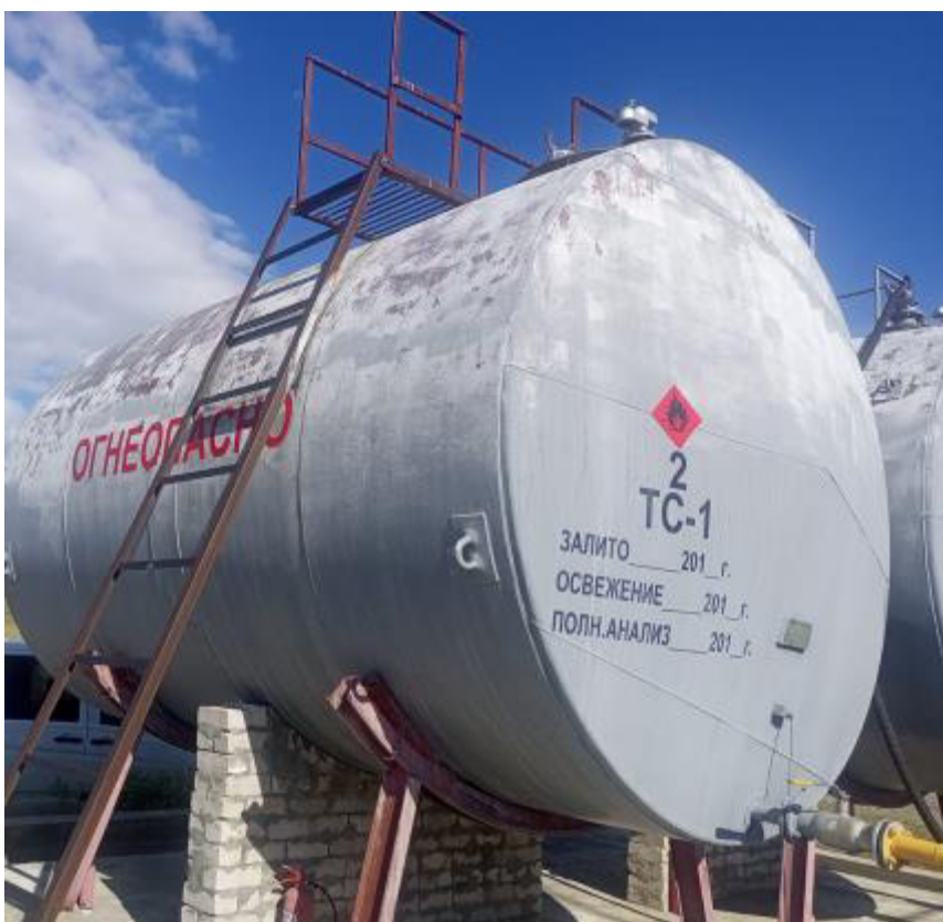
Рисунок 2 – Общий вид резервуара РГС-25 зав.№ 2
