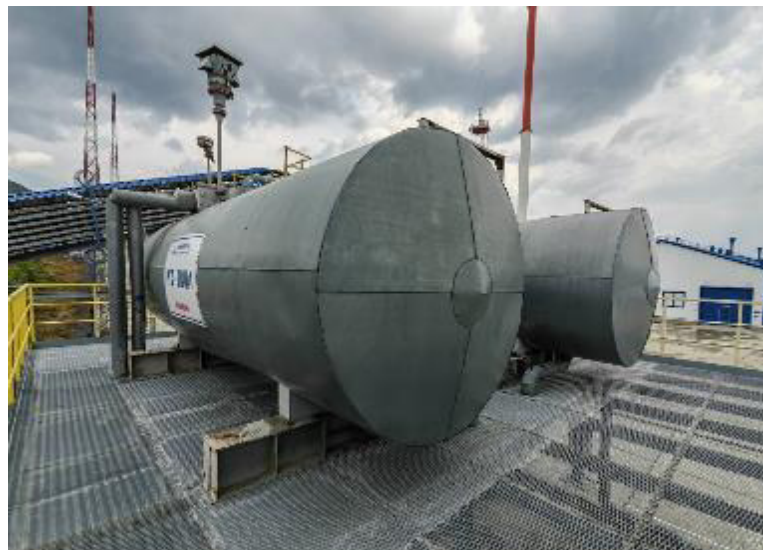
Рисунок 1 – Общий вид резервуаров РГС-20
