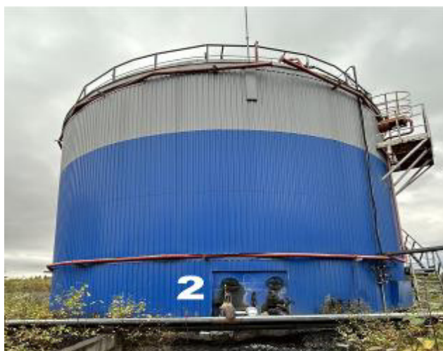
Рисунок 1 – Общий вид резервуара РВС-1000 зав. № 2
