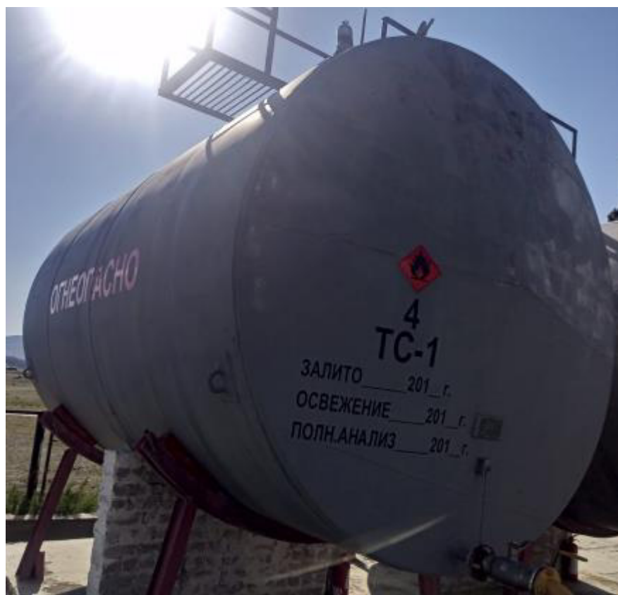
Рисунок 4 – Общий вид резервуара РГС-25 зав.№ 4
