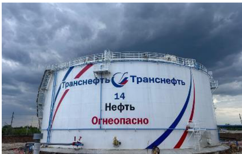
Рисунок 1 – Общий вид резервуара РВСП-10000
