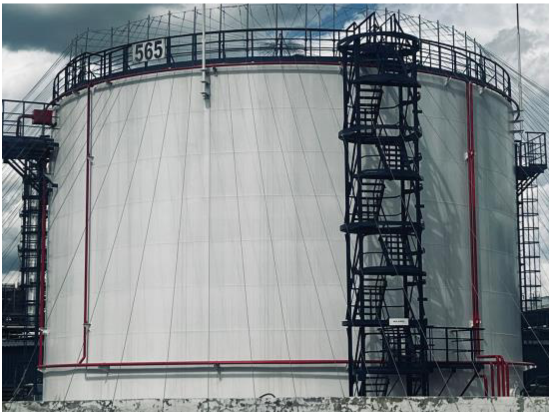
Рисунок 3 – Общий вид резервуара РВСП-3000 зав.№565
