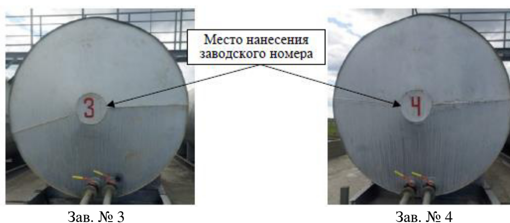
Рисунок 2 – Общий вид резервуаров модификации PГС-60
