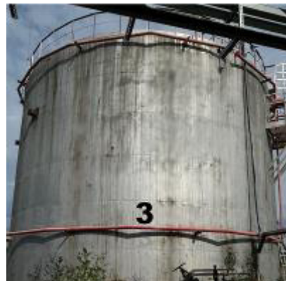
Рисунок 2 – Общий вид резервуара РВС-1000 зав. № 3
