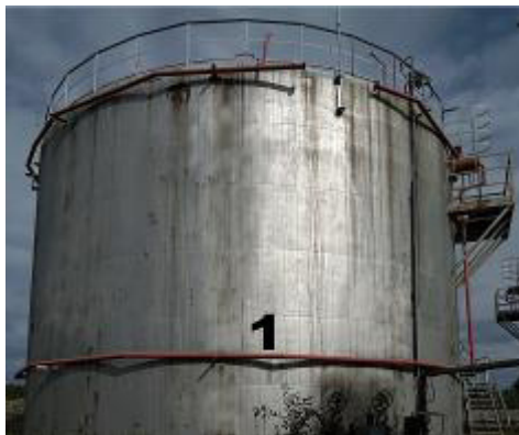
Рисунок 1 – Общий вид резервуара РВС-1000 зав. № 1
