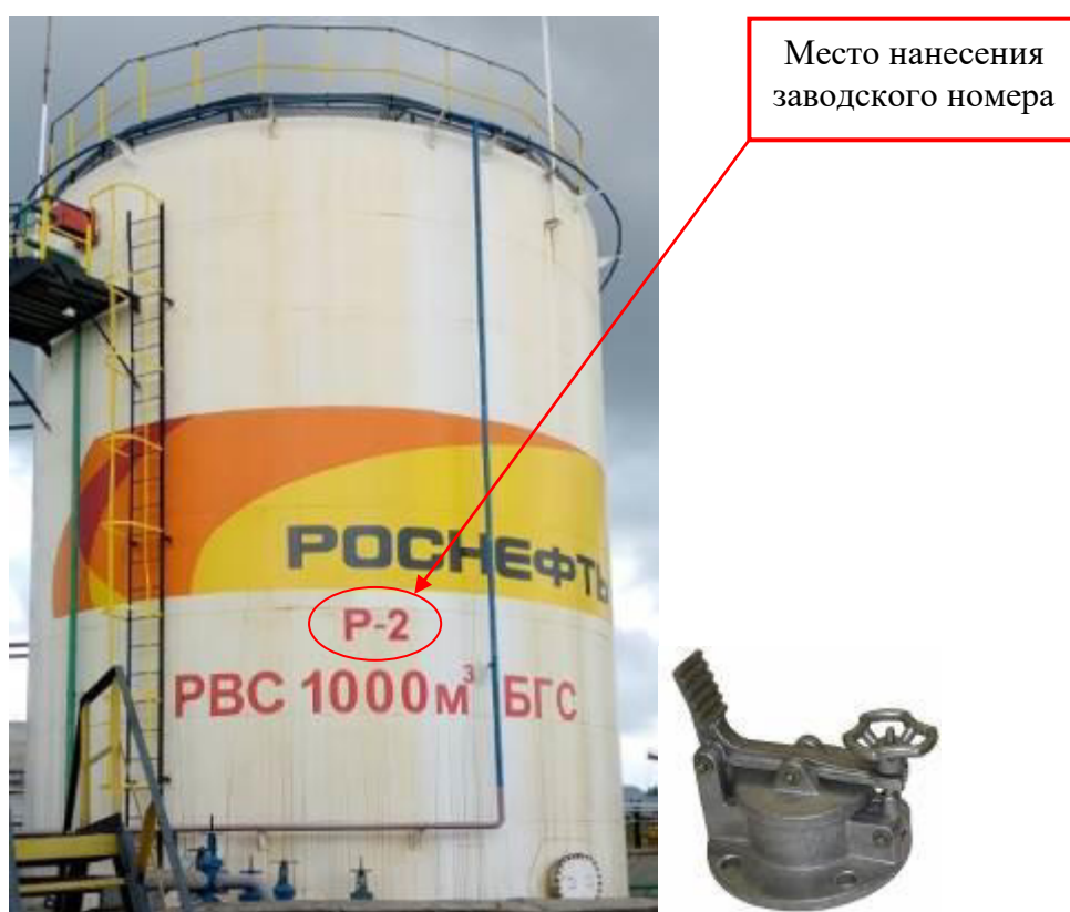
Рисунок 2 – Общий вид резервуара и замерного люка PBC-1000 зав. № P-2
