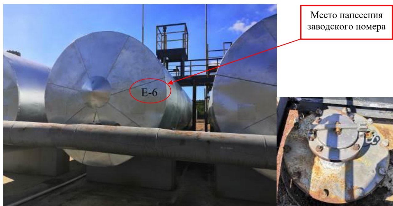
Рисунок 6 – Общий вид резервуара и замерного люка РГС-50 зав. № Е-6
