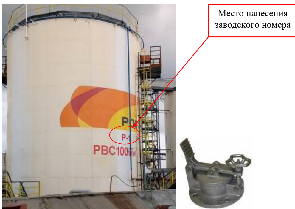
Рисунок 1 – Общий вид резервуара и замерного люка PBC-1000 зав. № P-1
