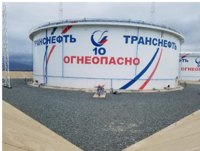
Рисунок 1 – Общий вид резервуара вертикального стального цилиндрического РВСПК-50000
