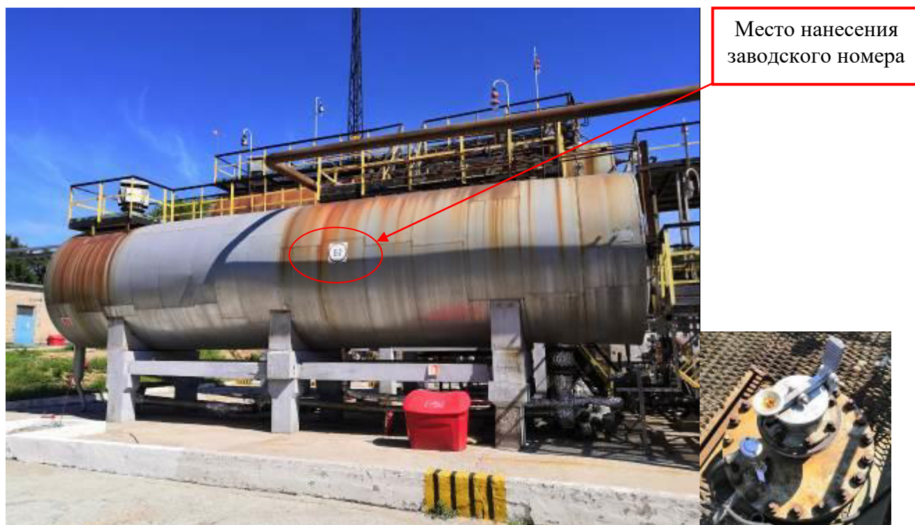
Рисунок 2 – Общий вид резервуара и замерного люка РГС-90 зав. № Е-2
