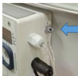
Монтаж термопреобразователя сопротивления Pt500 (500П) на корпусе счетчика
