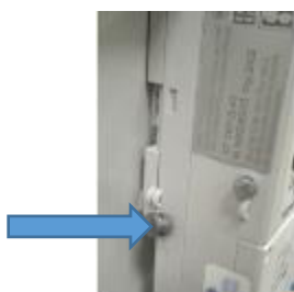
Монтаж термопреобразователя сопротивления Pt500 (500П) на корпусе счетчика
