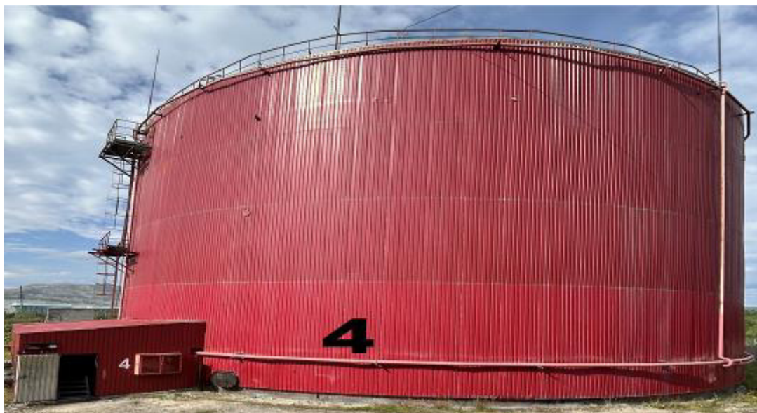
Рисунок 2 – Общий вид резервуара РВС-10000 зав. № 4
