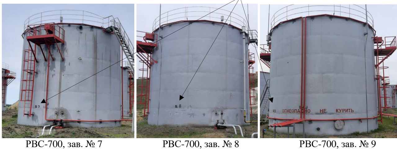
Рисунок 2 – Общий вид резервуаров, зав. № 4, 5, 6, 7, 8, 9
