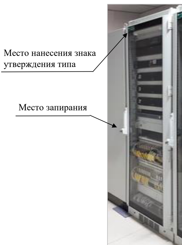
Рисунок 15 – Места расположения наклеек и запираения стойки приборной АИИС
