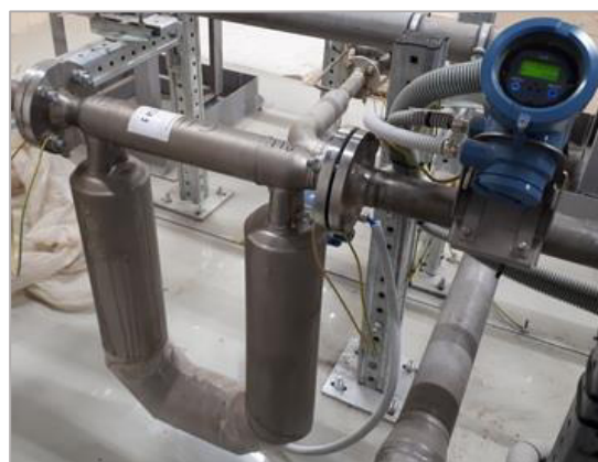
Рисунок 6 – Преобразователь расхода массового СМФ-200. Вид внешний
