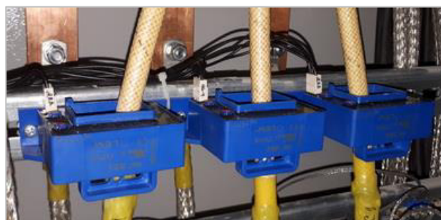
Рисунок 14 – Преобразователи силы тока первичные НАТ 200-S. Вид внешний
