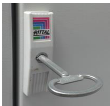
Рисунок 17 – Замок и ключ шкафа кроссового. Вид внешний
