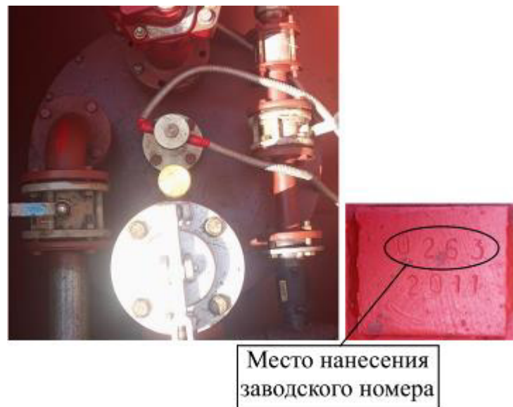
Рисунок 7 – Горловина и измерительный люк резервуара РГП 25-1-2(0,85)-О-У зав.№ 0263
