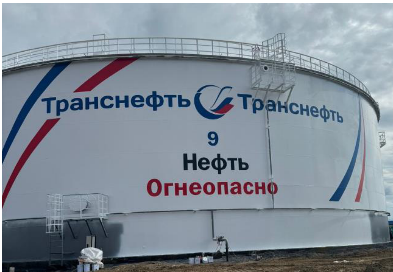
Рисунок 1 – Общий вид резервуара РВСП-20000 зав.№ 9
