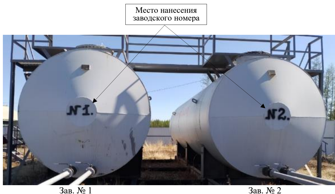
Рисунок 1 – Общий вид резервуаров
