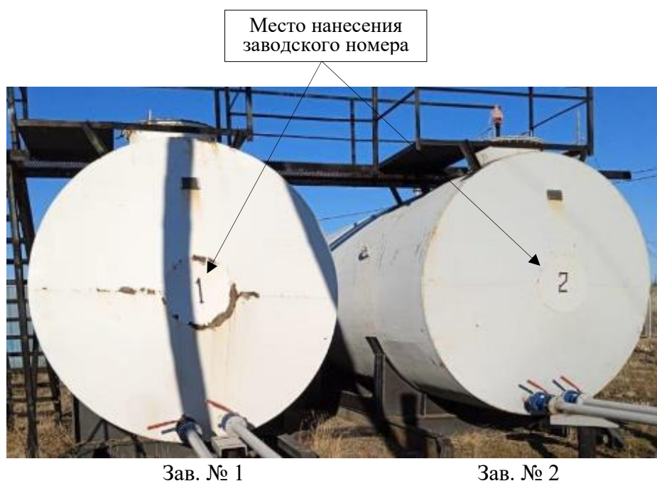
Рисунок 1 – Общий вид резервуаров
