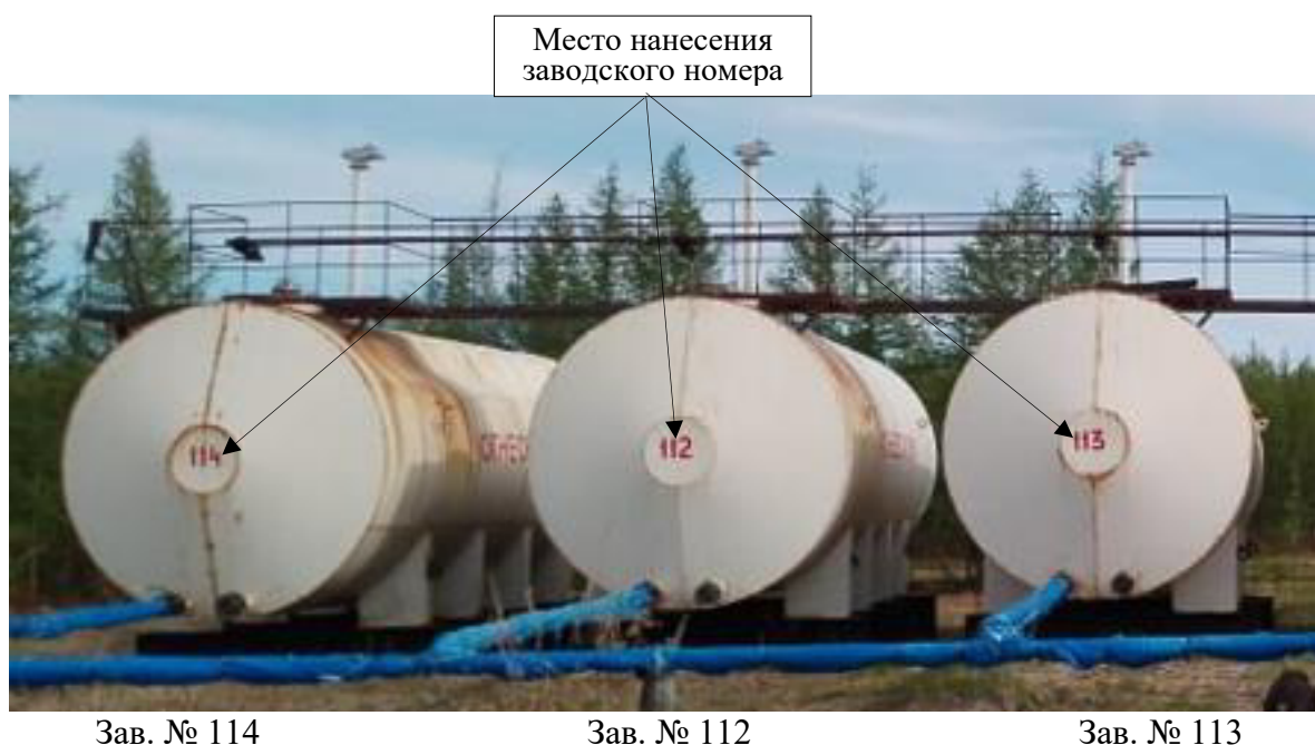
Рисунок 1 – Общий вид резервуаров, зав. № 114, 112, 113
