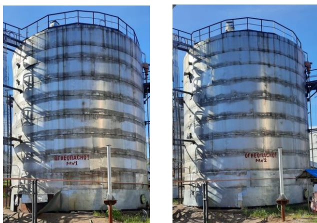
Рисунок 1 - Общий вид резервуаров стальных вертикальных цилиндрических РВС-1000
