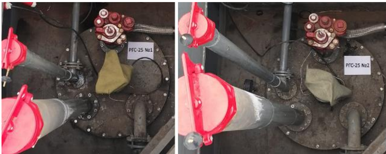
Рисунок 2 – Горловины резервуаров РГС-25 зав.№№ 1, 2
