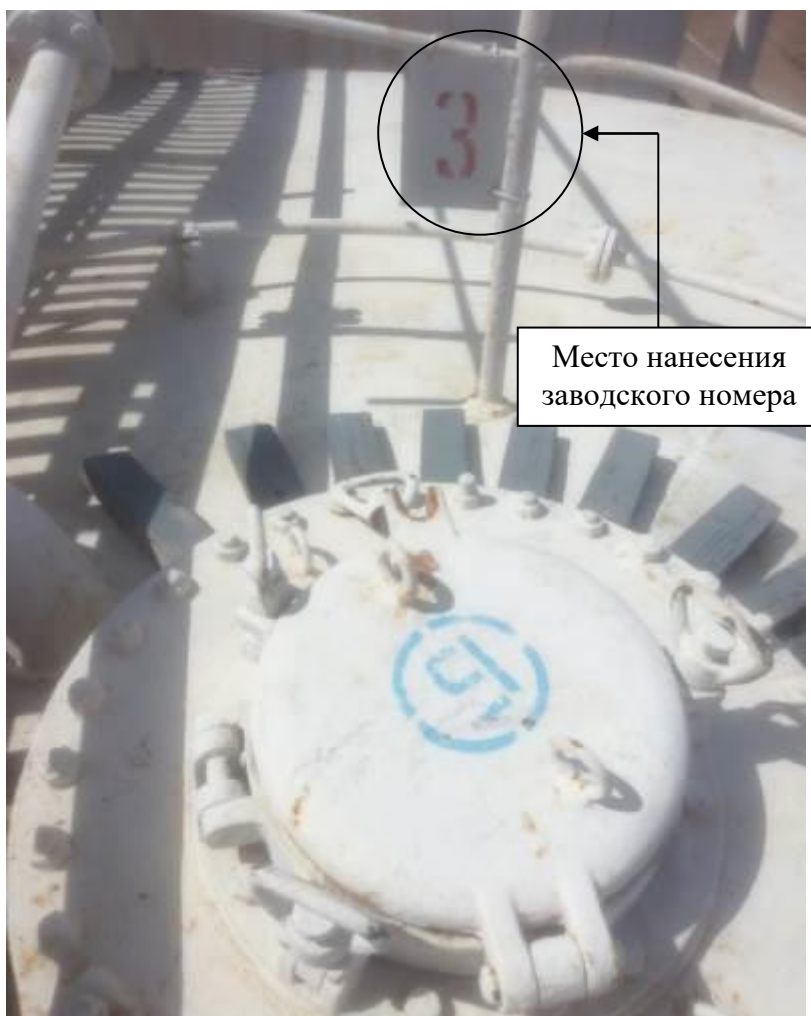
Р и с у н о к 3 – Общий вид замерного люка и места нанесения заводского номера
