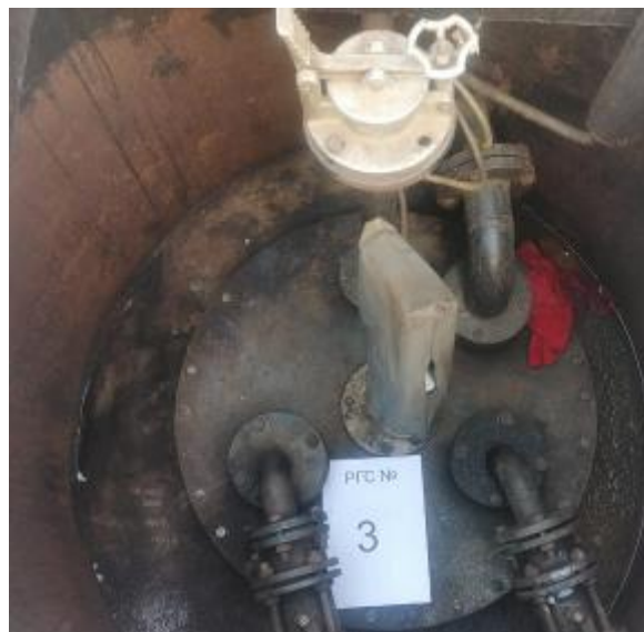
Рисунок 3 – Горловина резервуара РГС-73 зав.№3
