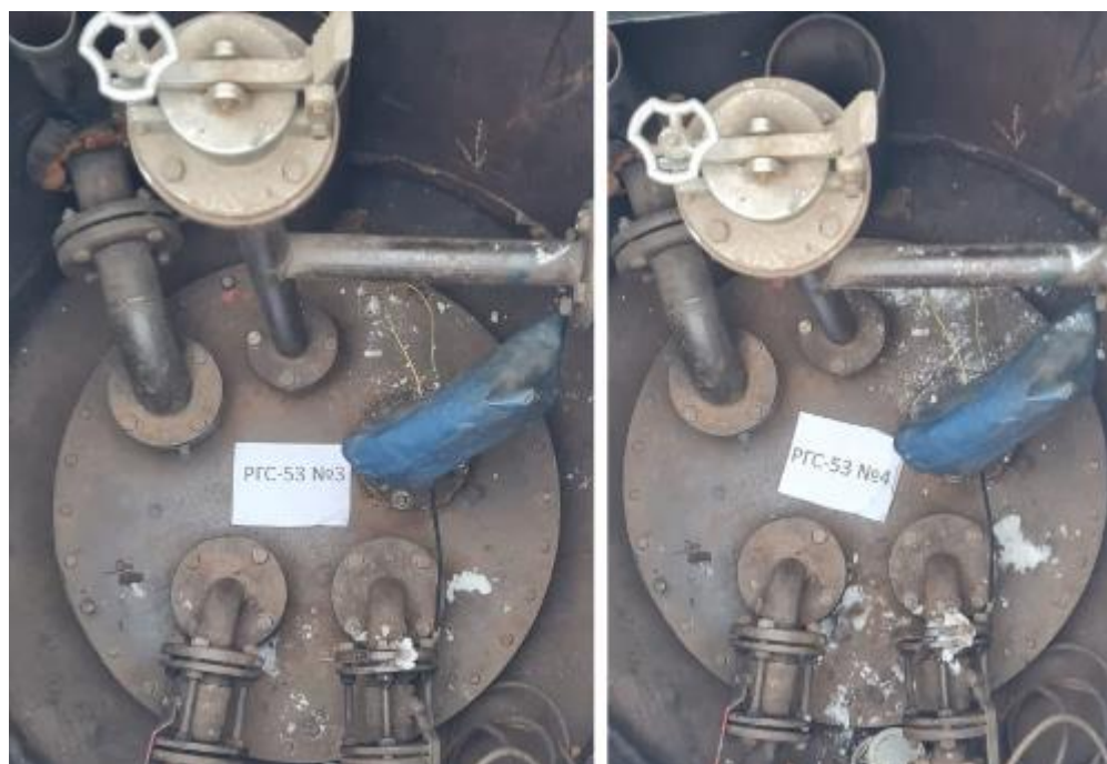
Рисунок 3 – Горловины резервуаров РГС-53 зав.№№ 3, 4
