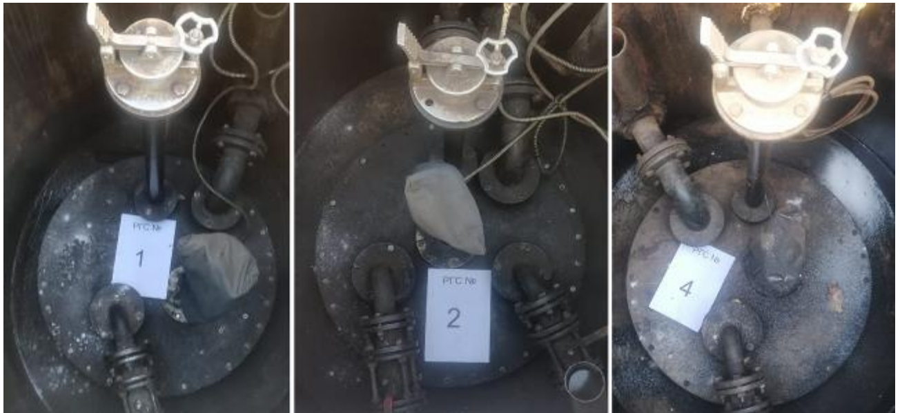
Рисунок 2 – Горловины резервуаров РГС-53 зав.№№ 1, 2, 4
