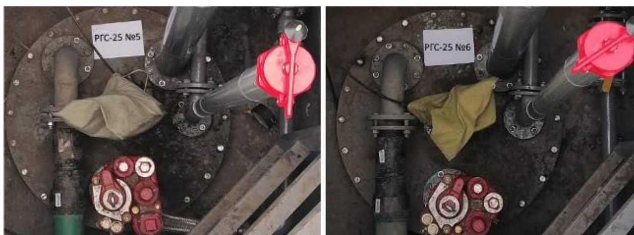
Рисунок 4 – Горловины резервуаров РГС-25 зав.№№ 5, 6
