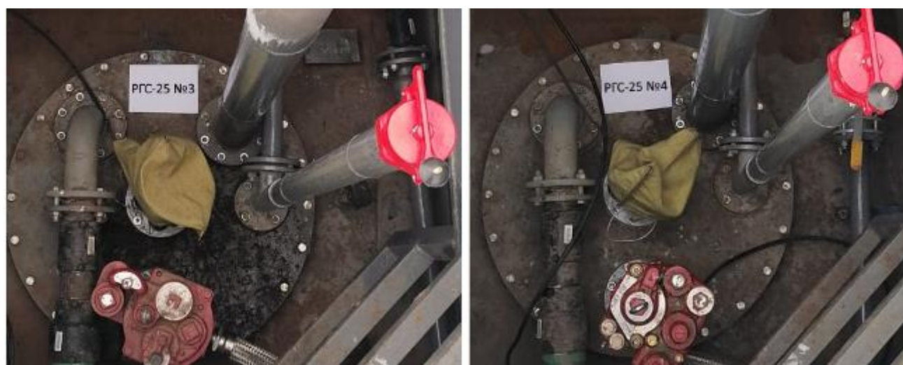
Рисунок 3 – Горловины резервуаров РГС-25 зав.№№ 3, 4
