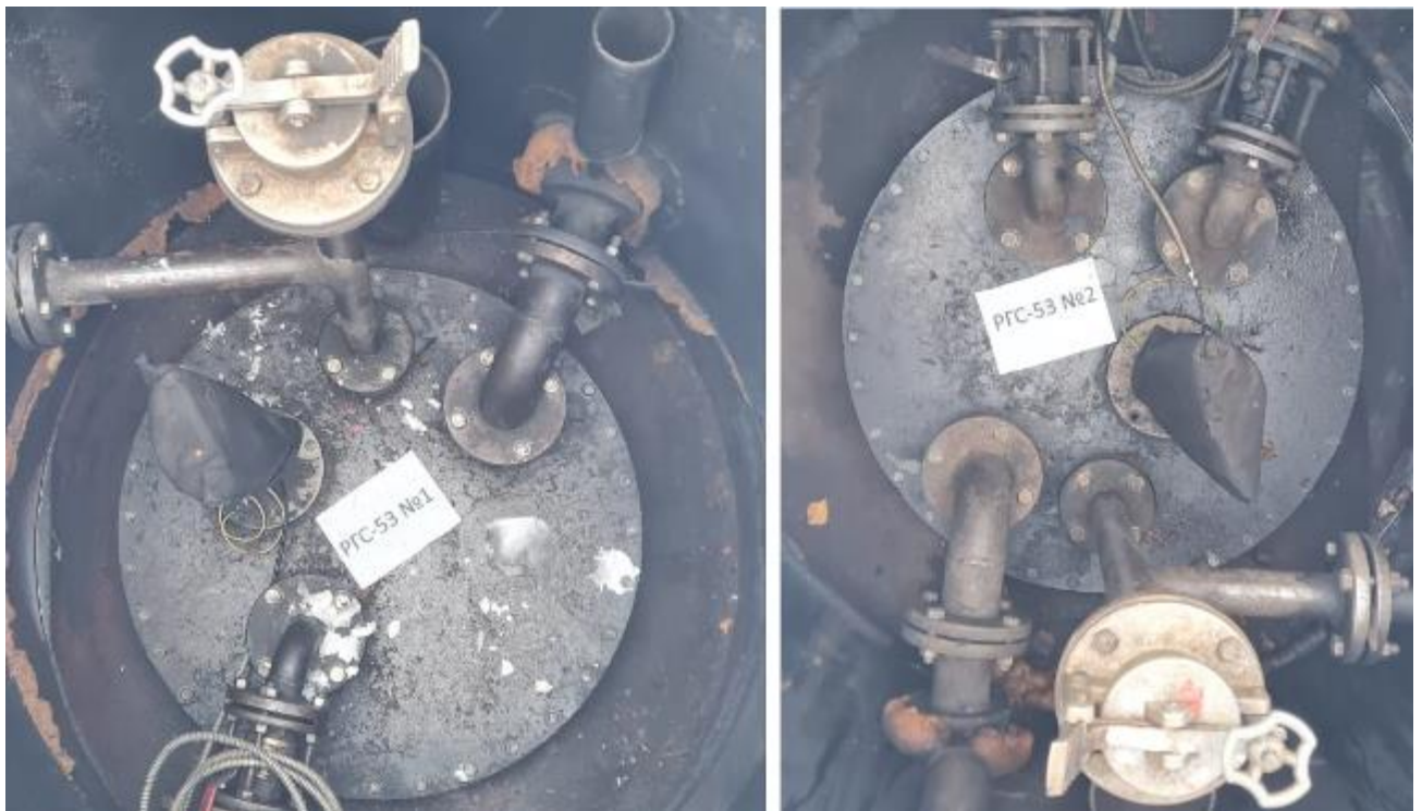
Рисунок 2 – Горловины резервуаров РГС-53 зав.№№ 1, 2
