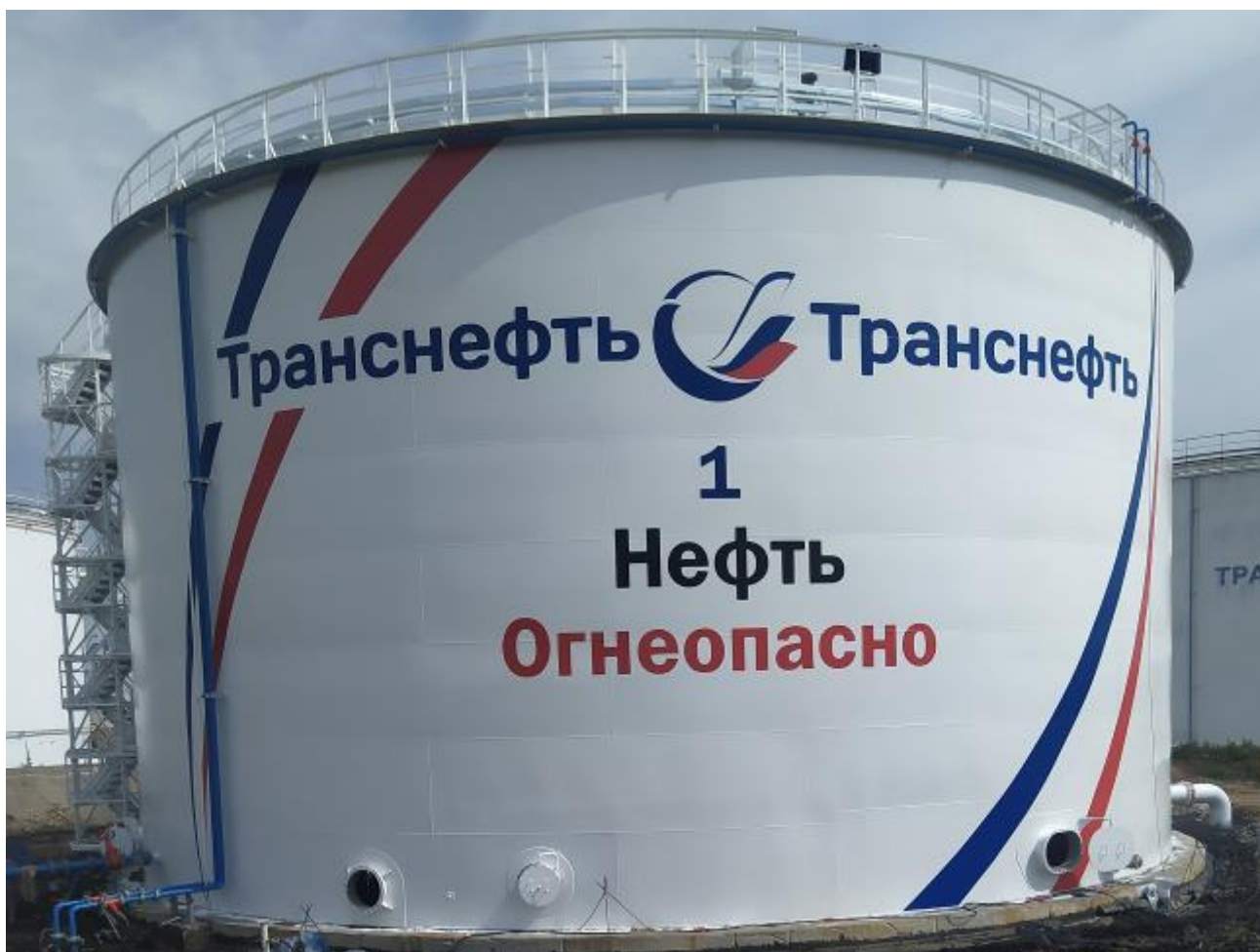
Рисунок 1 – Общий вид резервуара РВС-5000 №1
