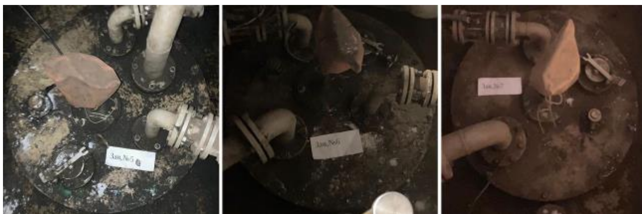
Рисунок 4 – Горловины резервуаров РГС-25 зав.№№ 5, 6, 7
