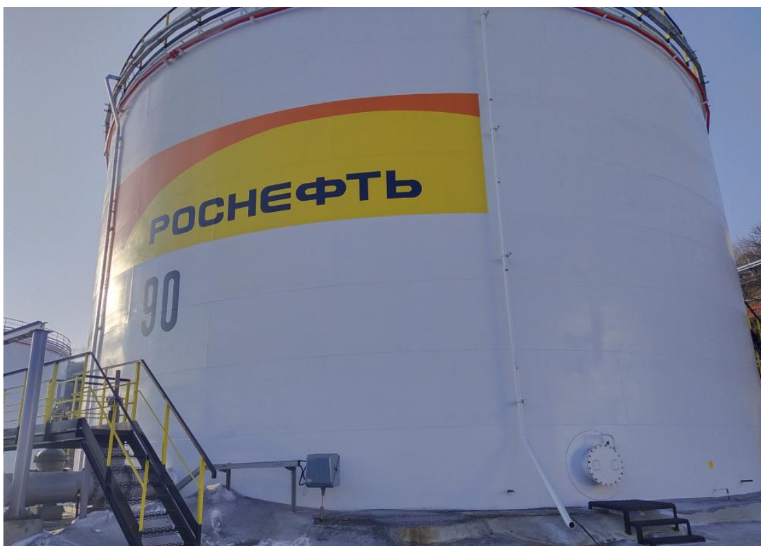
Рисунок 2 – Общий вид резервуара РВС-4899 зав.№ 90
