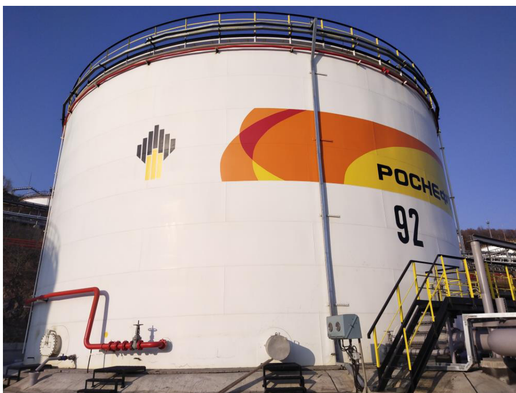
Рисунок 4 – Общий вид резервуара РВС-4899 зав.№ 92
