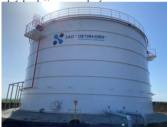
Рисунок 1 - Общий вид резервуара
