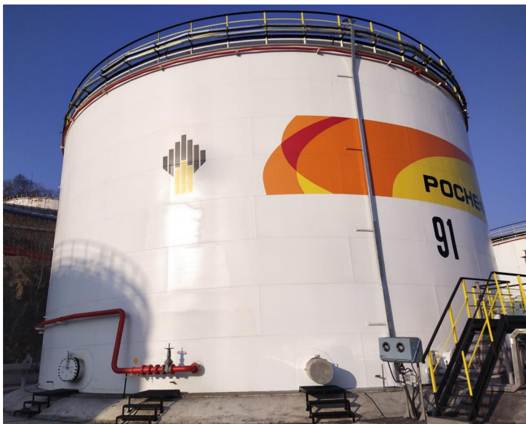
Рисунок 3 – Общий вид резервуара РВС-4899 зав.№ 91
