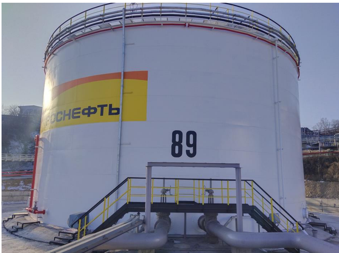
Рисунок 1 – Общий вид резервуара РВС-4899 зав.№ 89
