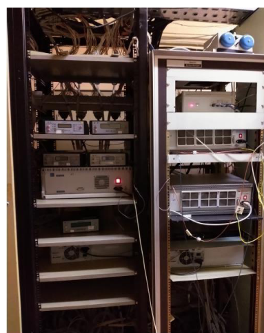
Рисунок 12 – Стойка с размещенными на ней МПС-036 и МЦП-2М
