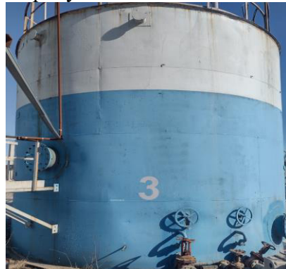
Рисунок 2 - Общий вид резервуара РВС-200 зав. № 3
