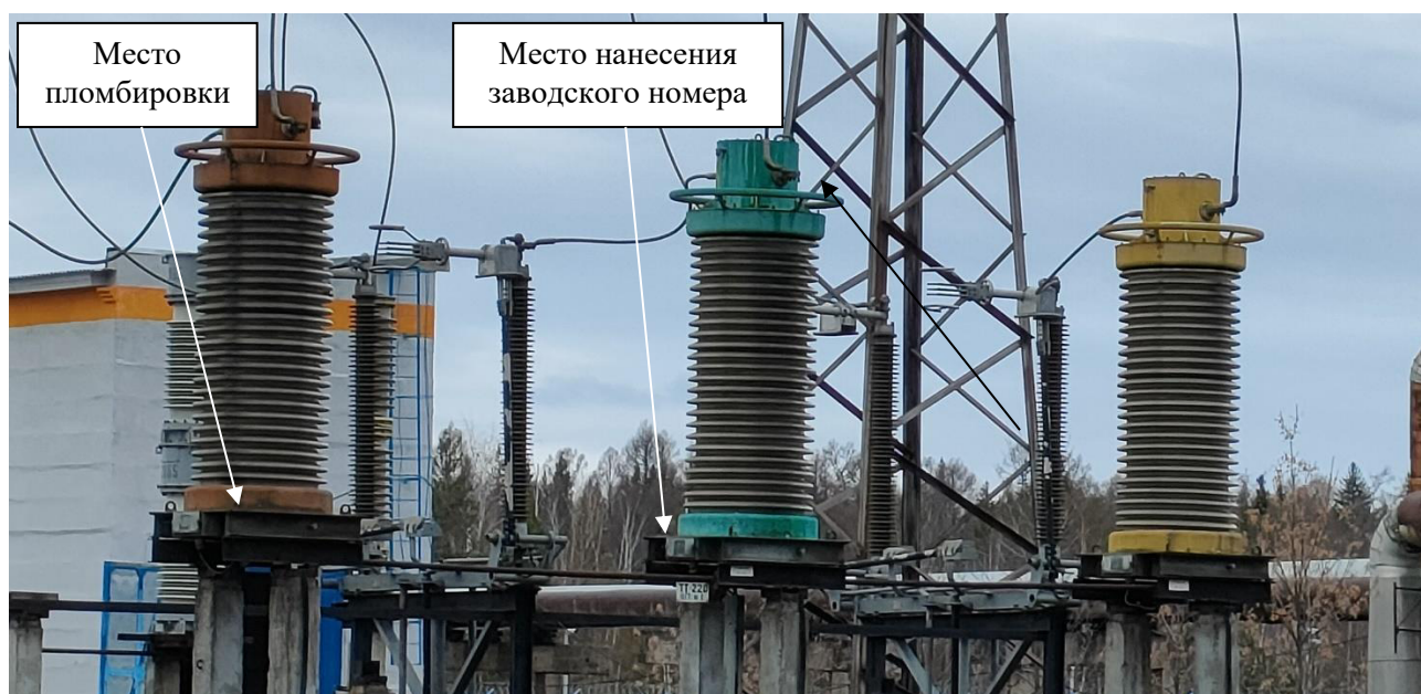
Рисунок 1 – Общий вид трансформаторов тока ТФЗМ 220Б-III У1 с указанием места пломбировки и места нанесения заводского номера
