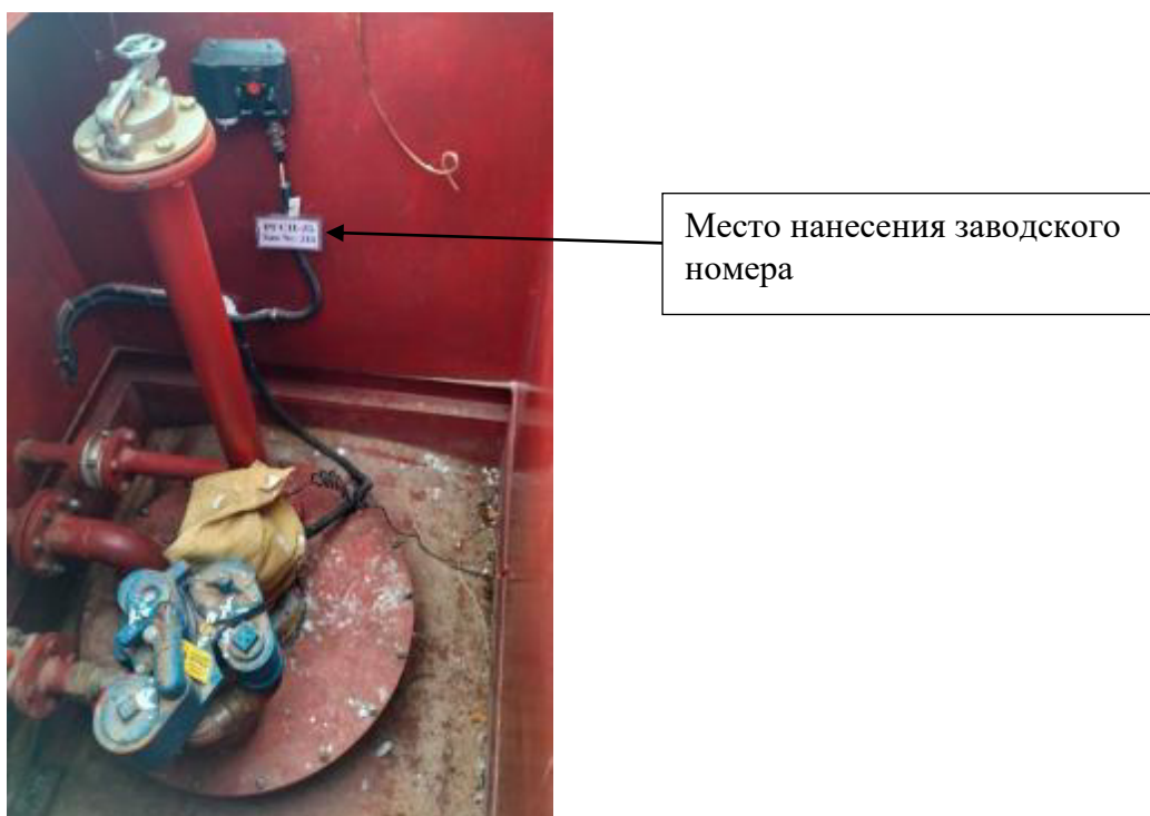
Рисунок 2 – фото горловины резервуаров горизонтальных стальных цилиндрических РГСН-25 с указанием места нанесения заводского номера
