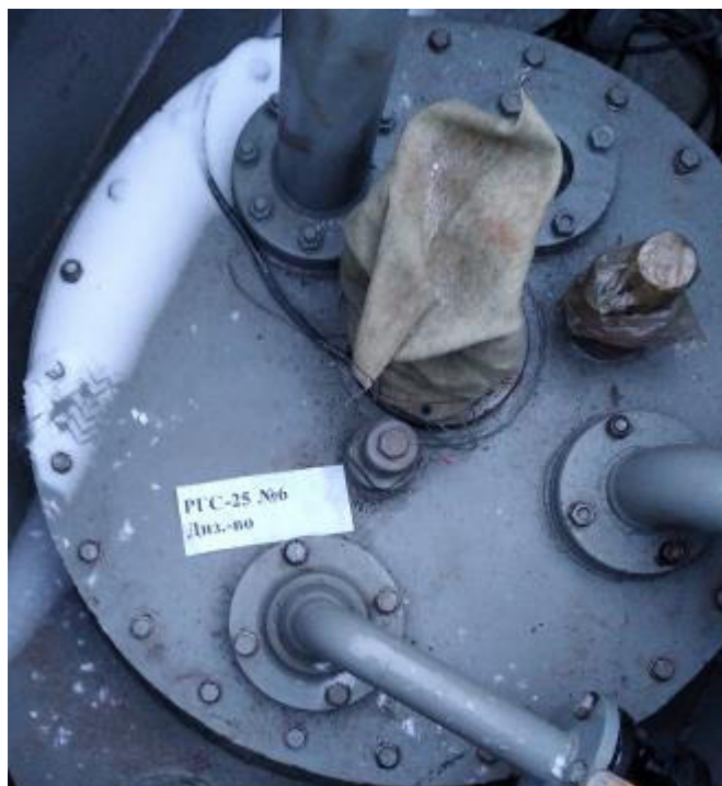
Рисунок 4 – Горловина резервуара РГС-25 зав.№ 6
