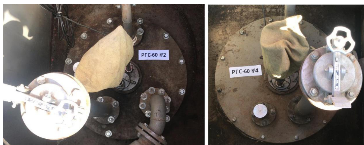
Рисунок 3 – Горловины резервуаров РГС-60 зав.№№ 2, 4
