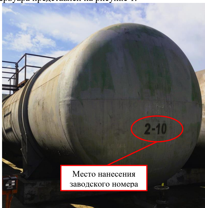
Рисунок 1 – Общий вид резервуара
