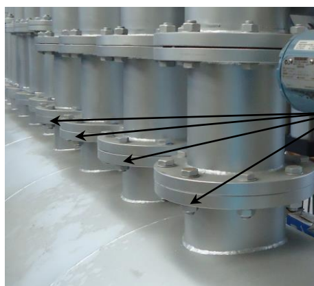
Рисунок 2 - Схема пломбировки от несанкционированного доступа, обозначение мест нанесения знака поверки на установке
