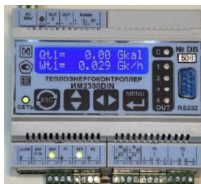
д) Приборы вторичные теплоэнергоконтроллеры ИМ2300
