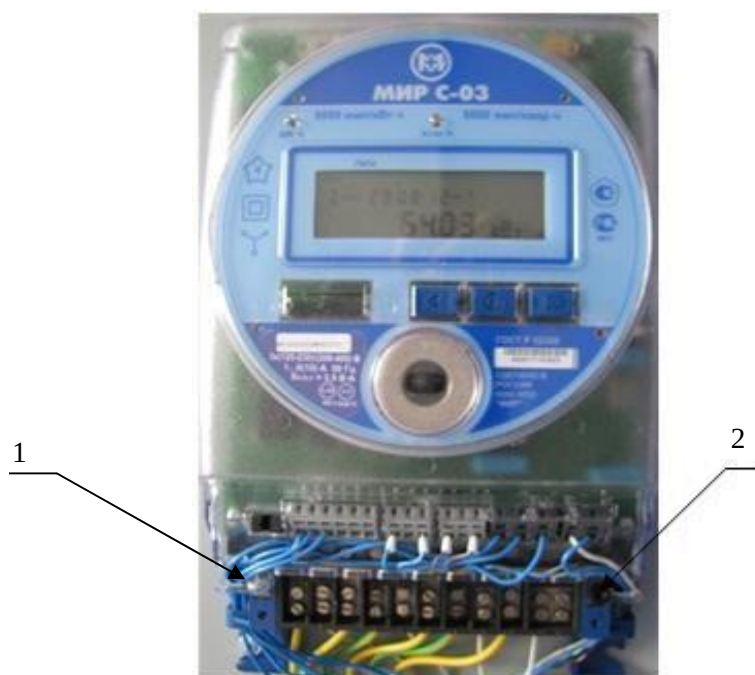
Р и с у н о к 1 – Общий вид и схема пломбирования клеммной крышки счетчиков модификации МИР-03
