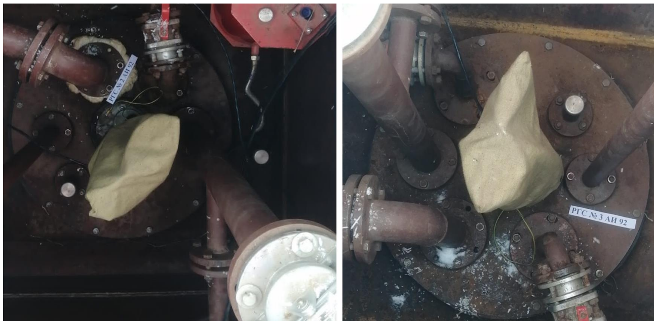
Рисунок 2 – Горловины резервуаров РГС-25 зав.№№ 2, 3
