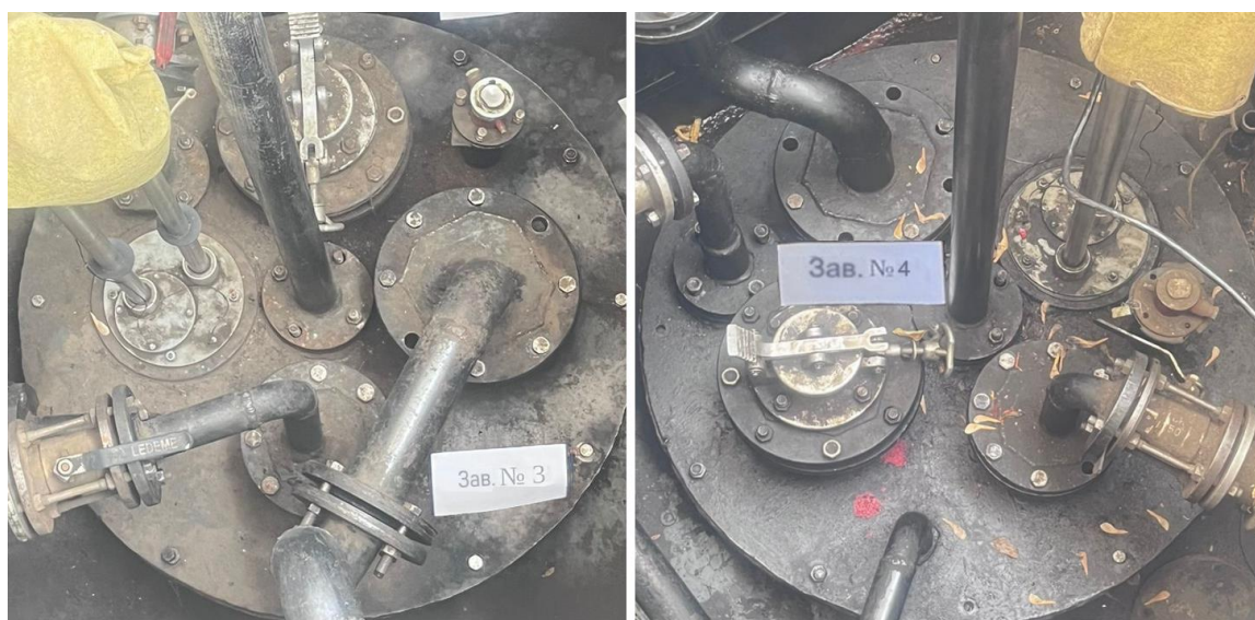
Рисунок 3 – Горловины резервуаров РГС-20 зав.№№ 3, 4
