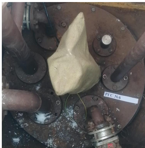
Рисунок 4 – Горловина резервуара РГС-25 зав.№ 6
