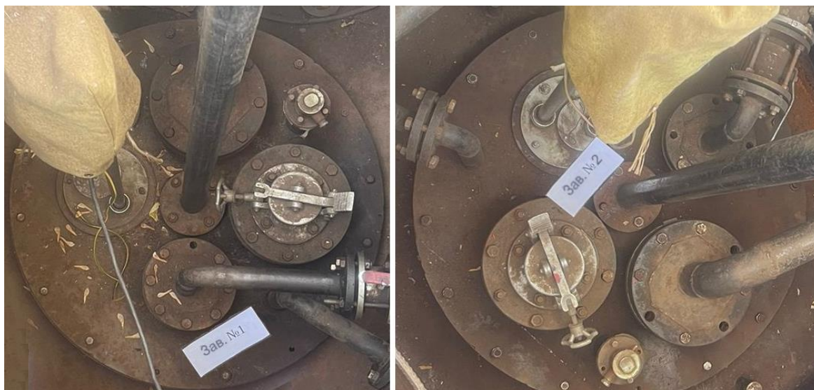
Рисунок 2 – Горловины резервуаров РГС-20 зав.№№ 1, 2
