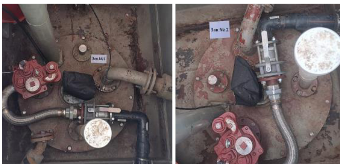
Рисунок 2 – Горловины резервуаров РГС-25 зав.№№ 1, 2
