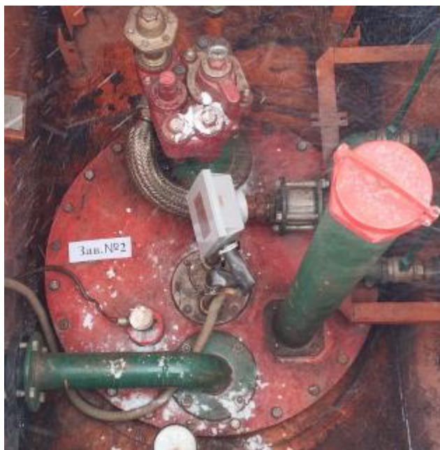
Рисунок 3 – Горловина резервуара РГС-60 зав.№ 2
