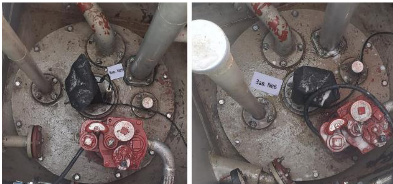
Рисунок 4 – Горловины резервуаров РГС-25 зав.№№ 5, 6
