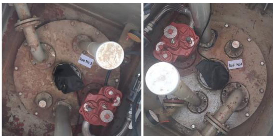
Рисунок 3 – Горловины резервуаров РГС-25 зав.№№ 3, 4
