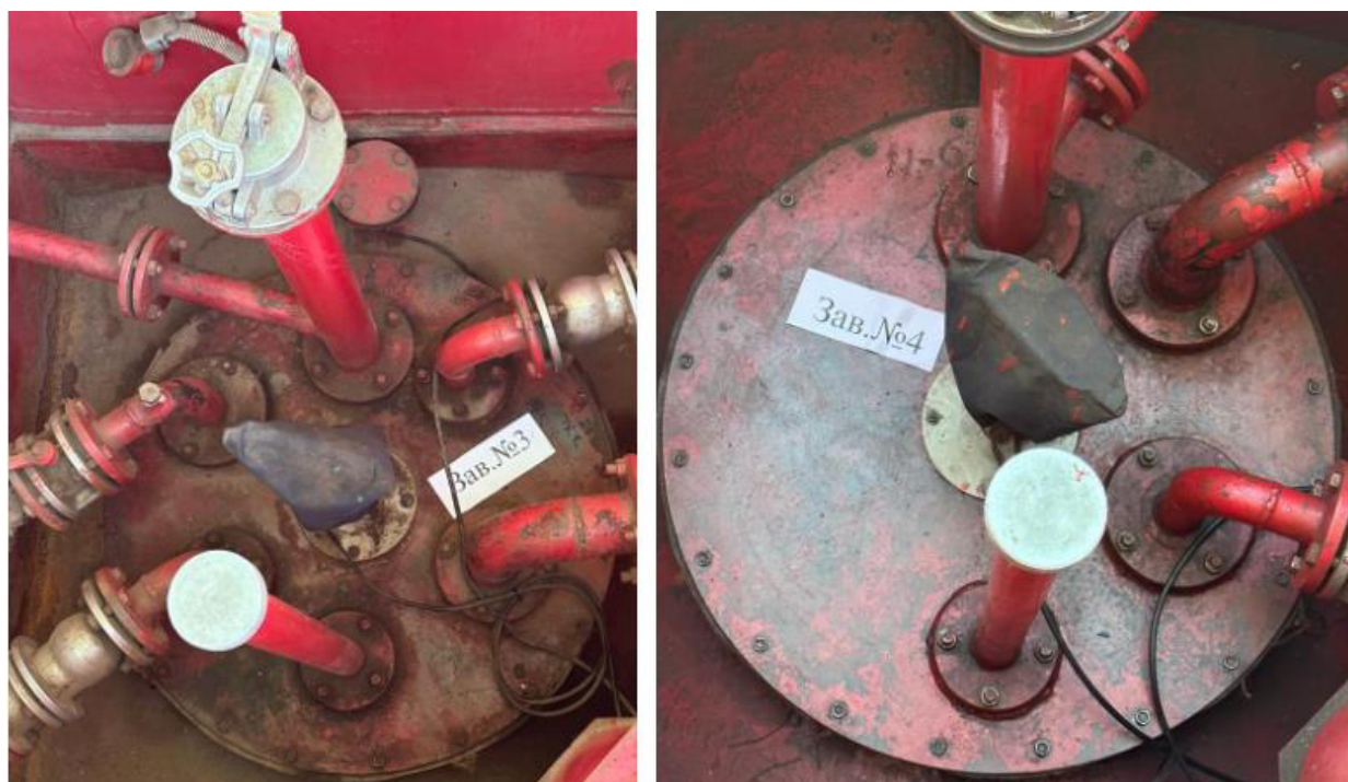
Рисунок 2 – Горловины резервуаров РГС-20 зав.№№ 3, 4
