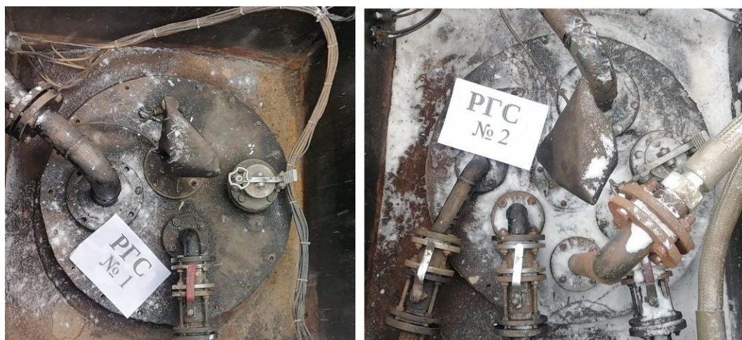
Рисунок 2 – Горловины резервуаров РГС-25 зав.№№ 1, 2
