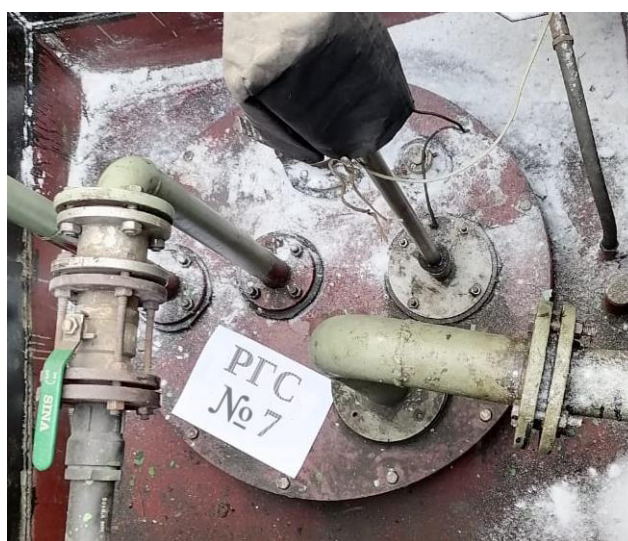
Рисунок 5 – Горловина резервуара РГС-25 зав.№ 7
