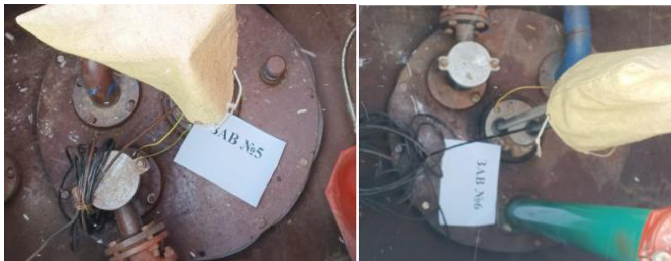
Рисунок 4 – Горловины резервуаров РГС-25 зав.№№ 5, 6
