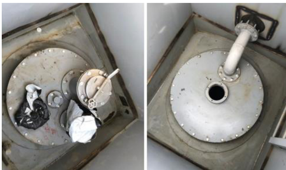
Рисунок 2 – Горловины и измерительный люк резервуара РГСпд-25 зав.№ 0372
