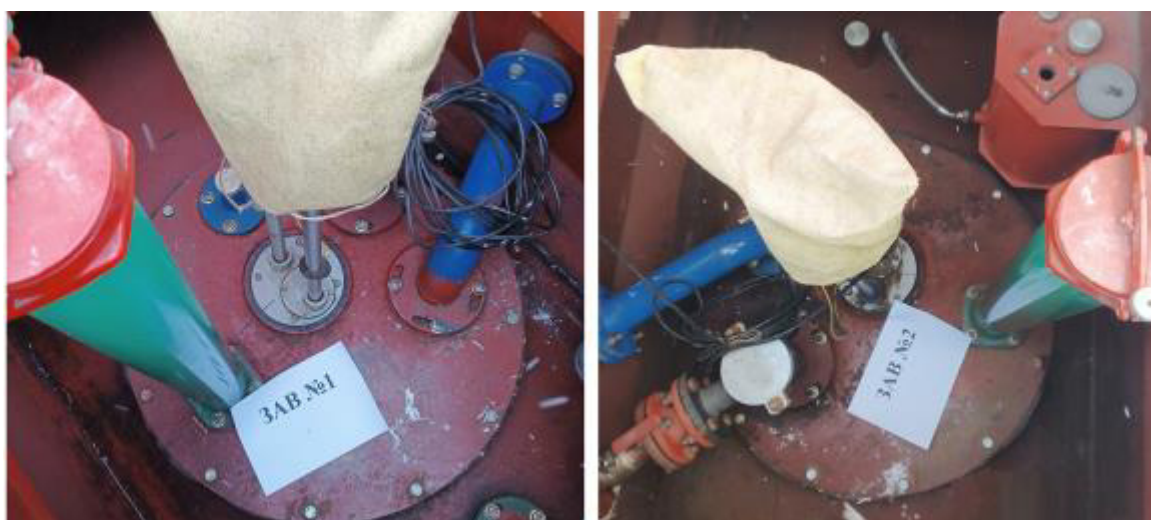
Рисунок 2 – Горловины резервуаров РГС-25 зав.№№ 1, 2
