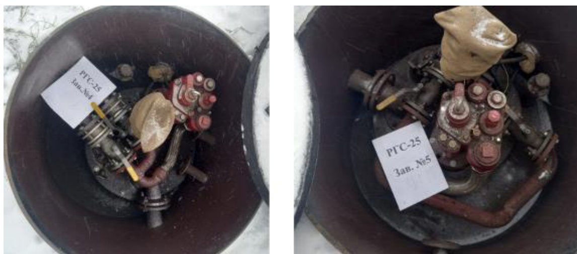
Рисунок 3 – Горловины резервуаров РГС-25 зав.№№ 4, 5
