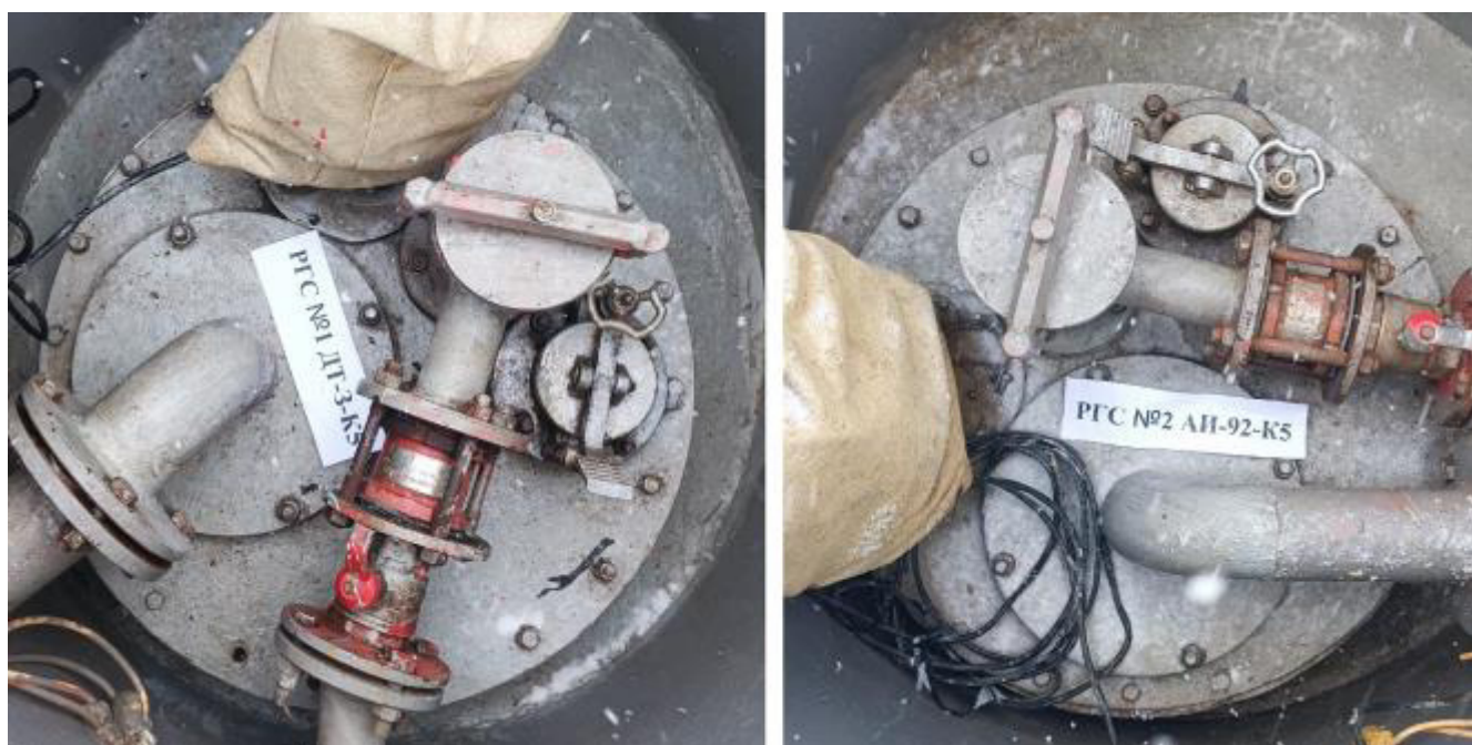
Рисунок 2 – Горловины резервуаров РГС-25 зав.№№ 1, 2
