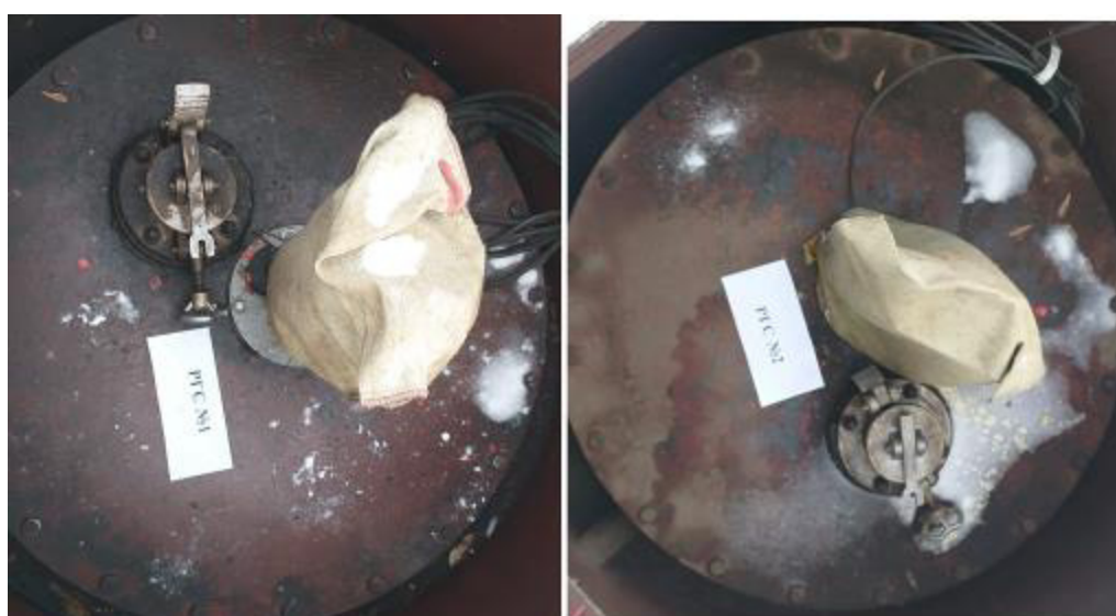
Рисунок 2 – Горловины резервуаров РГС-28 зав.№№ 1, 2
