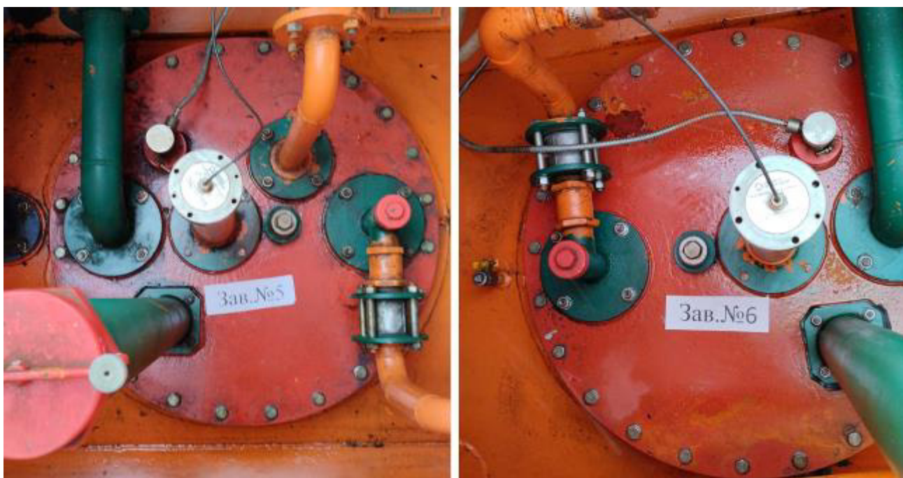
Рисунок 4 – Горловины резервуаров РГС-25 зав.№№ 5, 6
