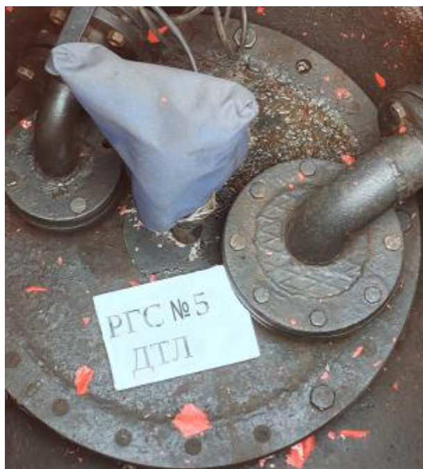
Рисунок 3 – Горловина резервуара РГС-60 зав.№ 5
