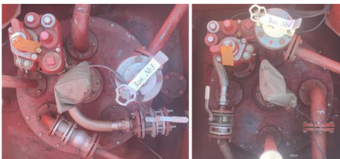
Рисунок 3 – Горловины резервуаров РГС-25 зав.№№ 3, 4
