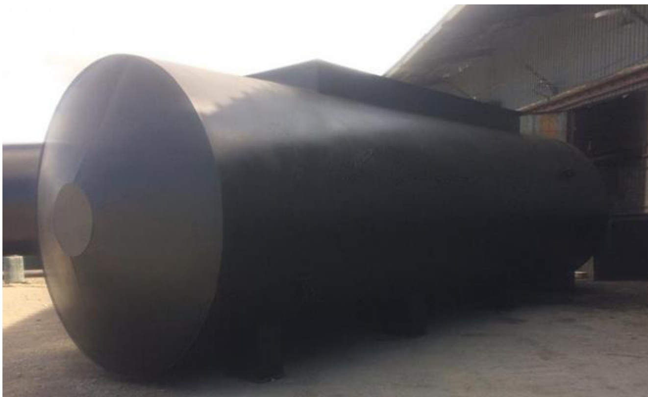
Рисунок 2 – Общий вид резервуара
