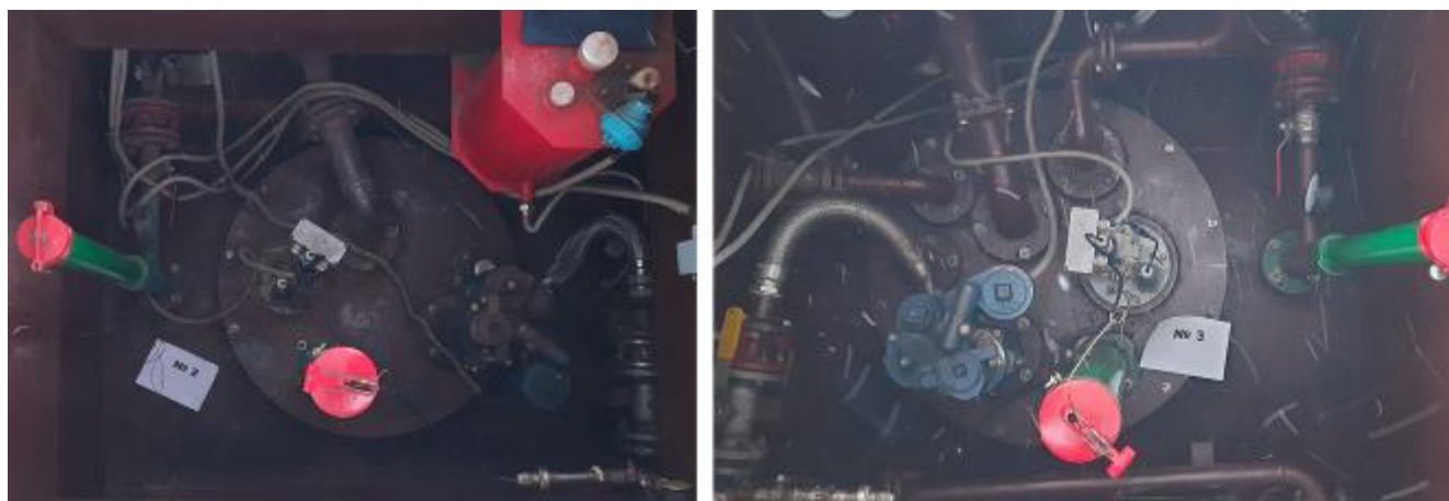
Рисунок 2 – Горловины резервуаров РГС-30 зав.№№2, 3
