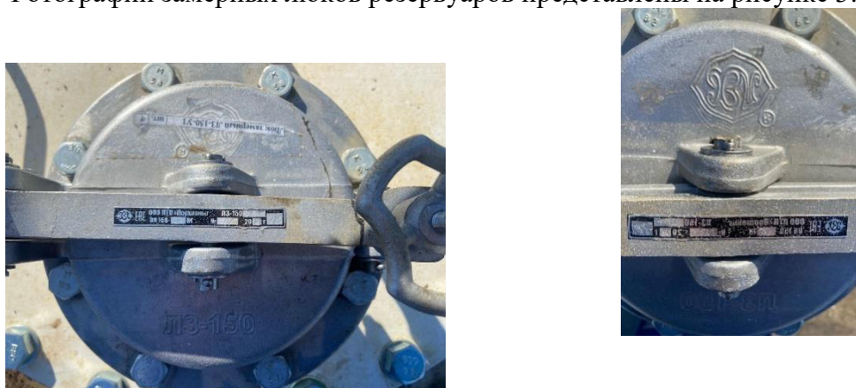
Рисунок 3 – Фотографии замерных люков резервуаров РГС-20
