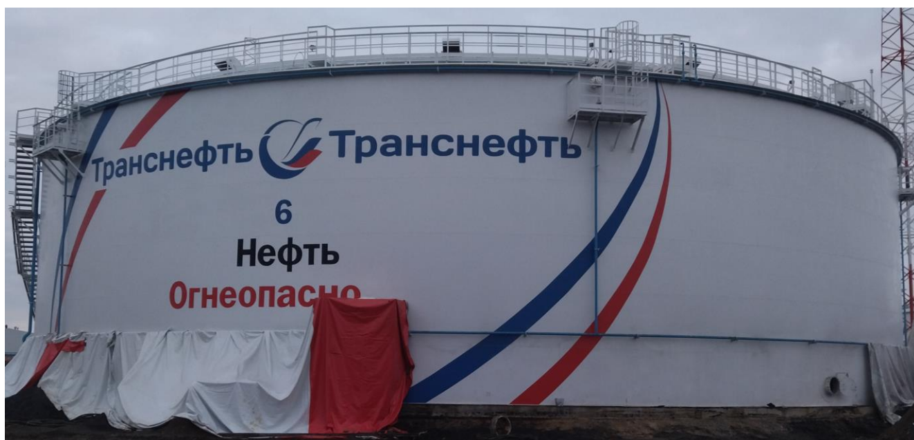
Рисунок 1 – Общий вид резервуара РВСП-20000 №6
