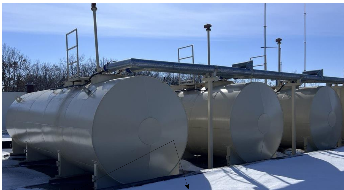
Рисунок 1 – Общий вид резервуаров
