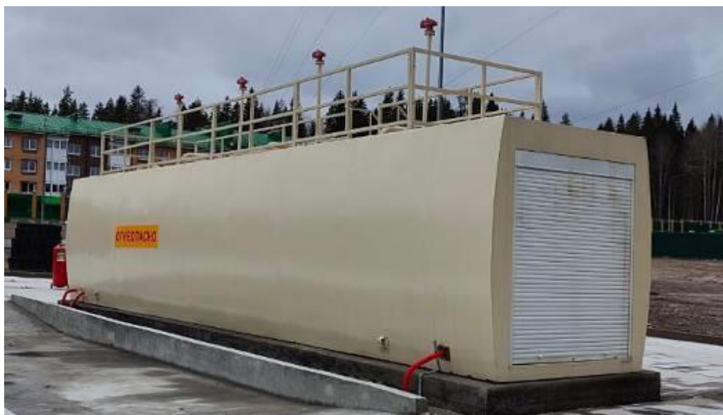
Рисунок 1 – Общий вид резервуара
