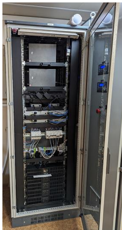
Рисунок 2 – Шкаф сервера
