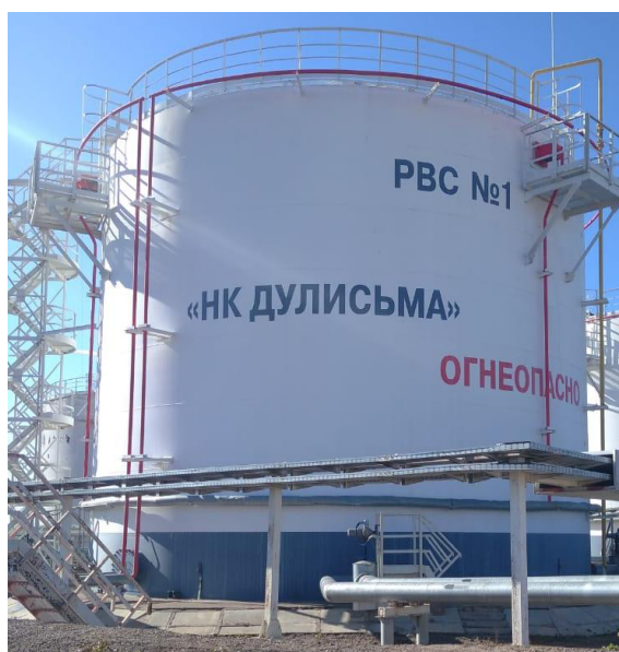
Рисунок 1 – Общий вид резервуара РВС-2000 зав. № 206
