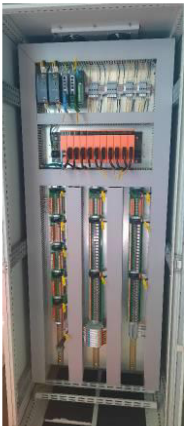
Рисунок 1 - Общий вид стойки модулей EFP2400 в электротехническом шкафу
