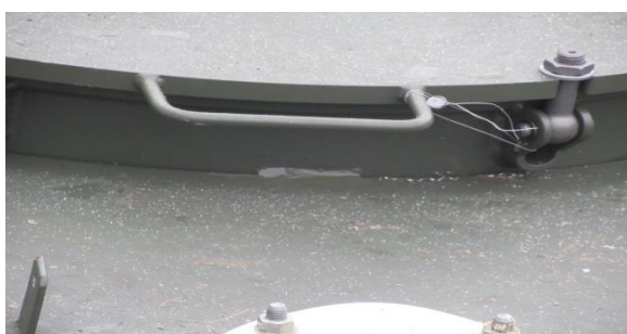
Рисунок 3 - Пломбировка горловины резервуара
