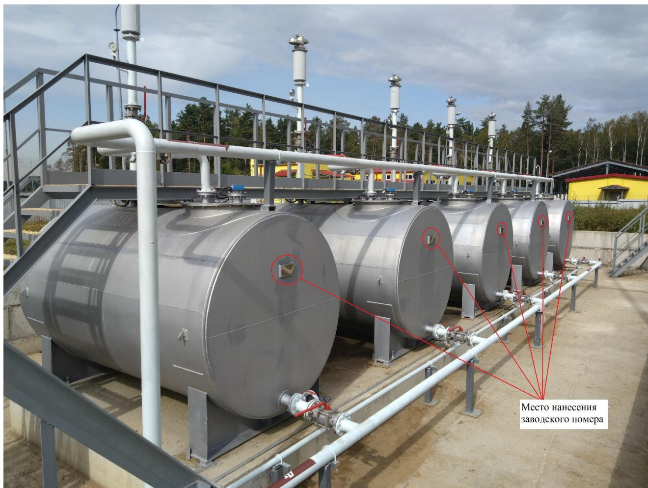
Рисунок 1 – Общий вид резервуаров
