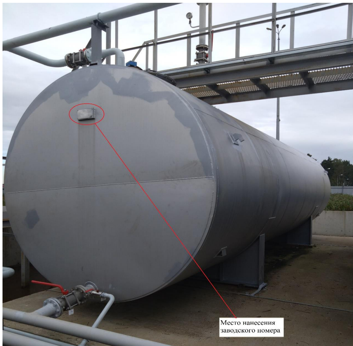
Рисунок 1 – Общий вид резервуаров
