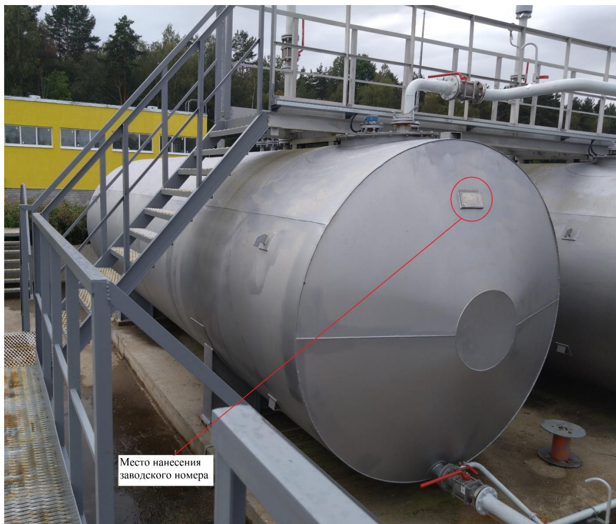
Рисунок 1 – Общий вид резервуаров
