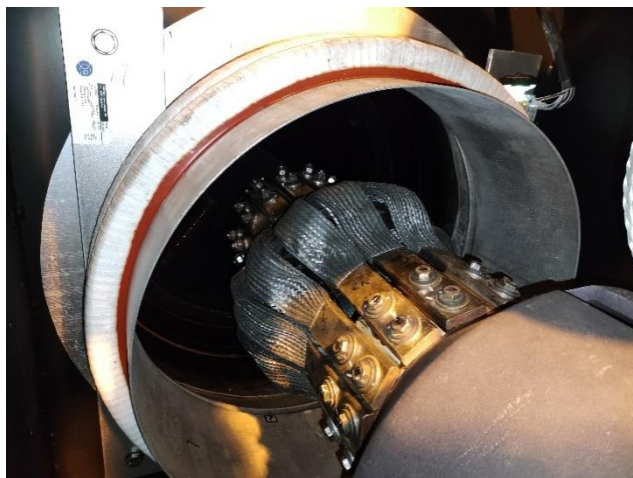
Рисунок 1 – Внешний вид трансформаторов
