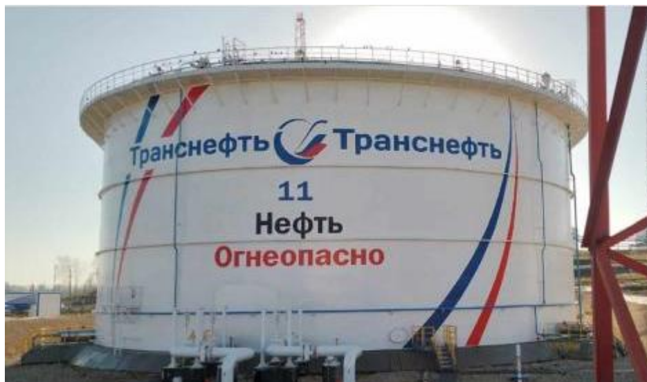
Рисунок 1 – Общий вид резервуара
