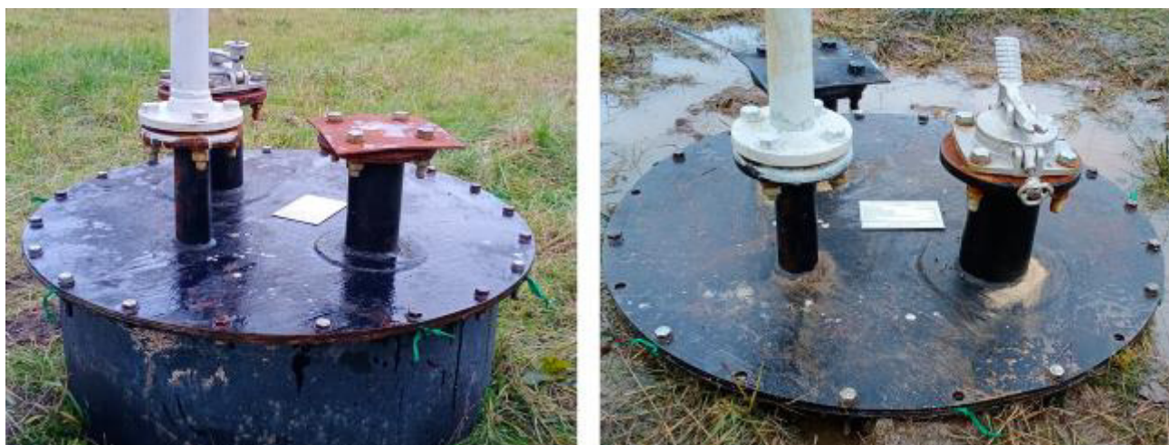
Рисунок 6 – Горловины и измерительные люки резервуаров РГСП-50
