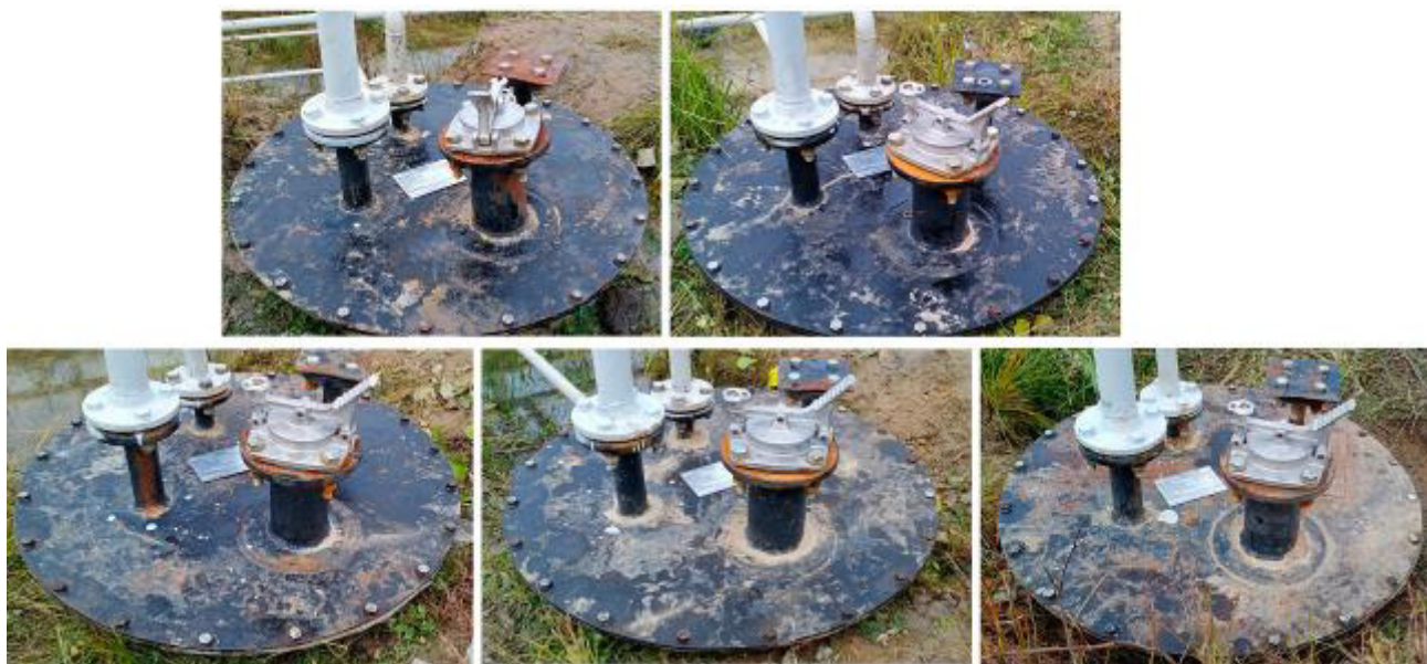
Рисунок 4 – Горловины и измерительные люки резервуаров РГСП-4
