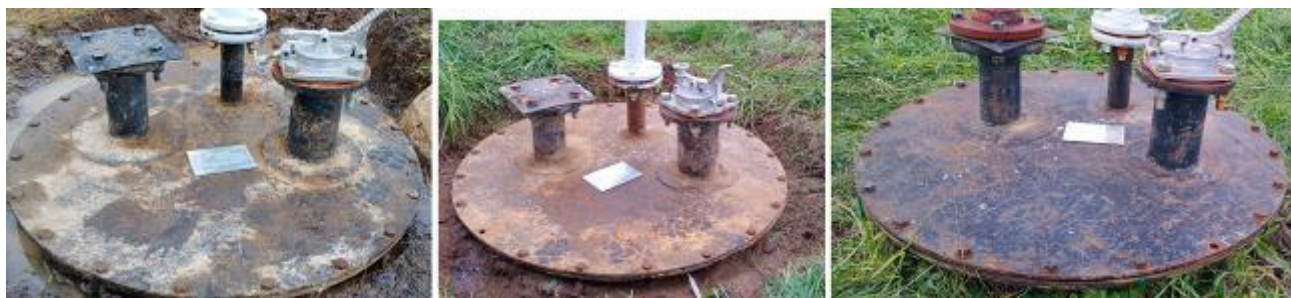
Рисунок 5 – Горловины и измерительные люки резервуаров РГСП-10
