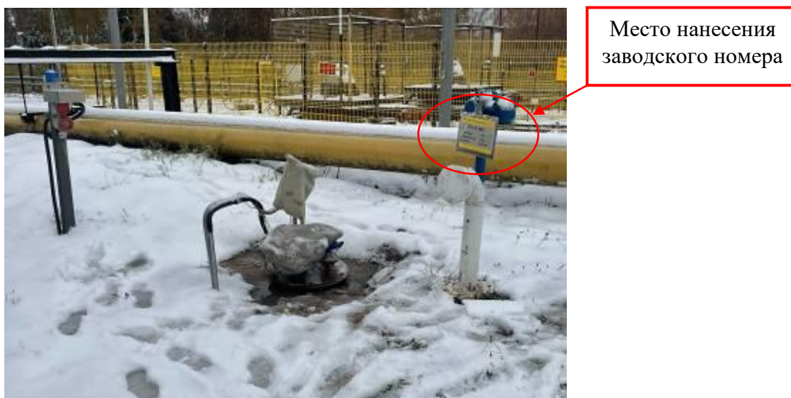
Рисунок 2 – Общий вид заливной горловины РГС-22 зав.№ 11
