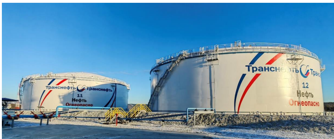
Рисунок 1 – Общий вид резервуаров РВСП-50000
